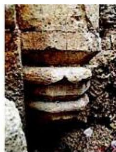
Konzola koja nosi polustup na spoju južnog i istočnog zida svetišta u kapeli utvrde
