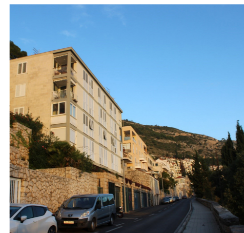
7.1 Suvremena višestambena izgradnja – Ploče, Ulica Petra Krešimira IV
