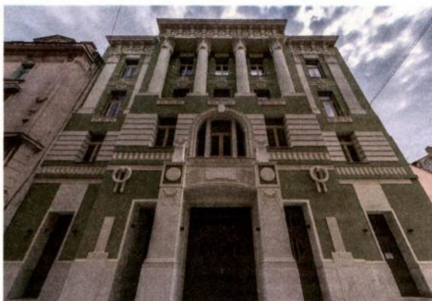
Zgrada je nakon dugogodišnjeg skrivanja iza skela i obloga doslovno zablistala i uljepšala frekventni dio Splita
