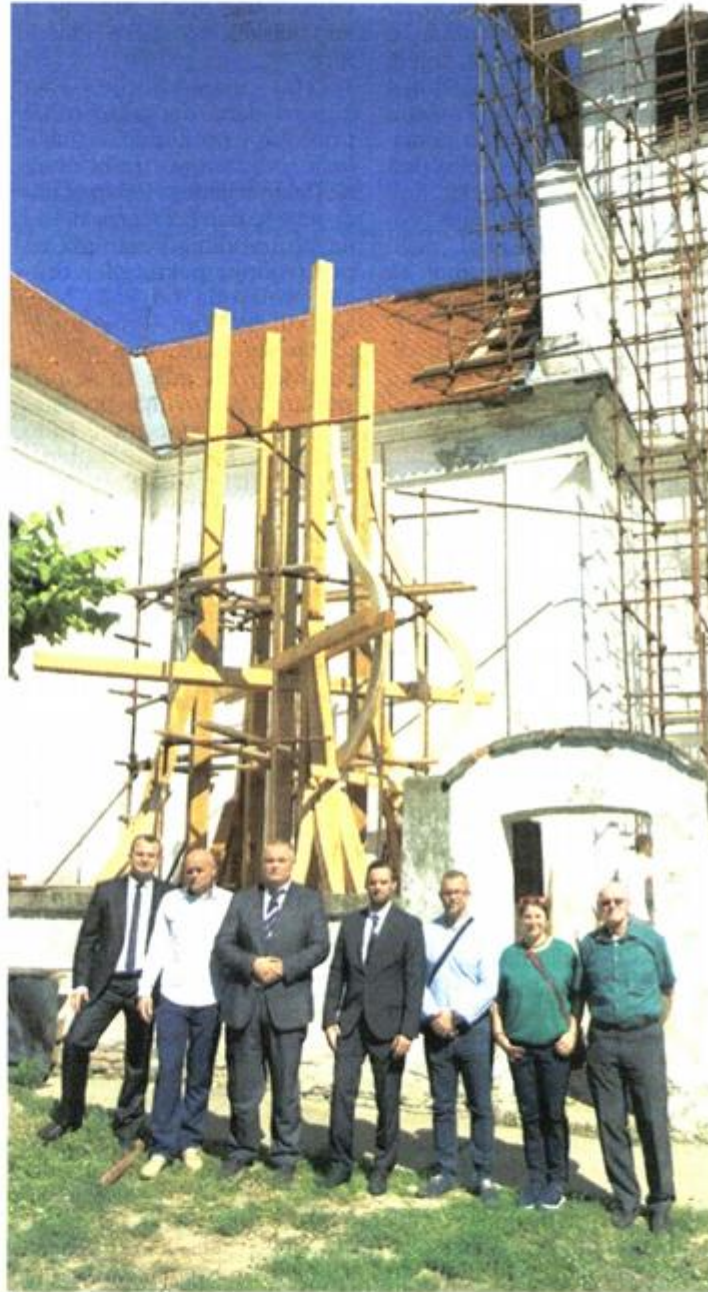
Obnova tornja reformatske crkve u Vardarcu završit će u listopadu
