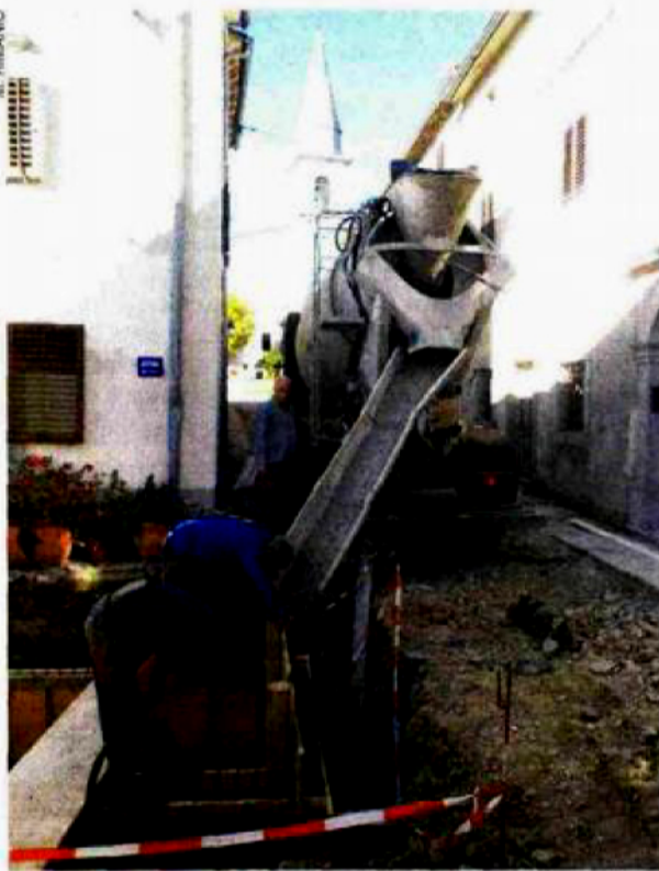
Gradnja kanalizacije u Draguču
