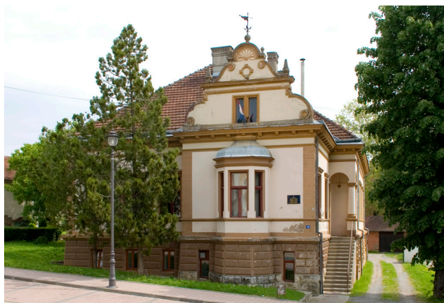
Zgrada porezne uprave, mjesto prvog postava MZSDK 1971.
