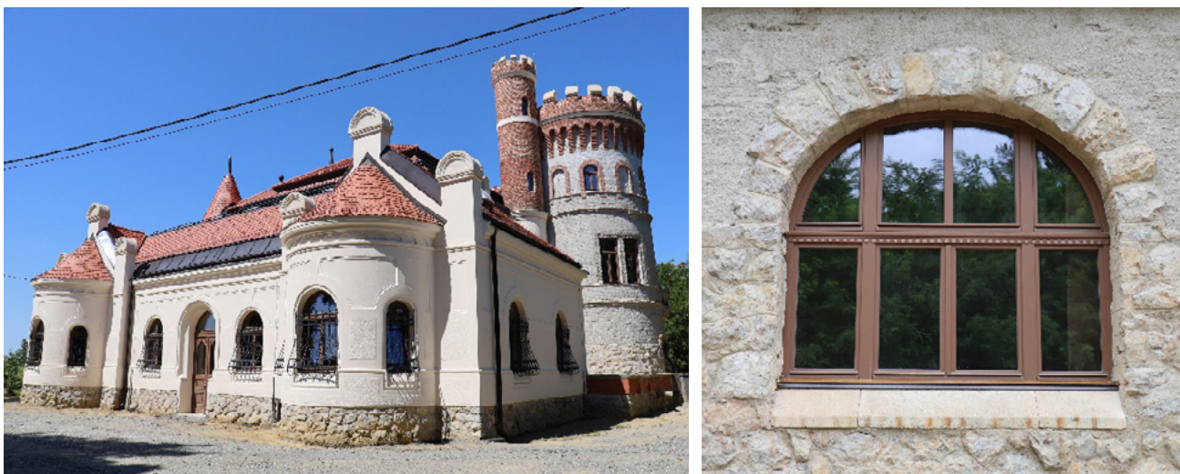
Slika 15. Pogled na dvorac Dioš – rezidencijalnu građevinu nadomak Končanice (lijevo), zamjenski prozor s nadsvjetlom (desno)
