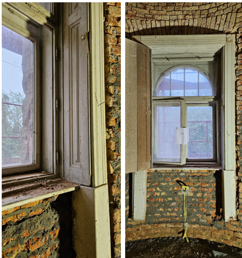
Slika 16. Dvostruki prozor s razmaknutim krilima i nadsvjjetlom. Donja se krila otvaraju zaokretno, a gornja su otklopna. Vanjsko krilo nadsvjjetla je lučno, unutarne pravokutno. Prozor ima dekorativni opšav s bočnim kutijama u koje se sklapaju unutarnja drvena sjenila.
