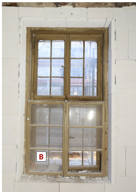
Slika 8. Na dva tipična prozora vanjska i unutarnja krila se otvaraju zaokretno. Podjela u polja napravljena je pomoću drvenih letvica. Gledano s unutarnje strane, sva krila djeluju zdravo. Uz pretpostavku da su svi izvorni prozori imali jednaku profilaciju i izgled, dimenzije letvica na lijevoj slici (A) te podjela unutarnjih krila u polja na desnoj (B), kao i različite zglobnice ukazuju na to da se ovdje (A) radi replikama koje nisu usklađene s izvornim proizvodima (B).
