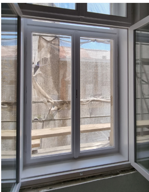
Slika 2b. Prozor s dvostrukim krilima tipa Beč karakterizira otvaranje svih krila prema unutra, pri čemu su unutarnja krila većih dimenzija od vanjskih
