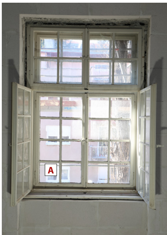
Slika 8. Na dva tipična prozora vanjska i unutarnja krila se otvaraju zaokretno. Podjela u polja napravljena je pomoću drvenih letvica. Gledano s unutarnje strane, sva krila djeluju zdravo. Uz pretpostavku da su svi izvorni prozori imali jednaku profilaciju i izgled, dimenzije letvica na lijevoj slici (A) te podjela unutarnjih krila u polja na desnoj (B), kao i različite zglobnice ukazuju na to da se ovdje (A) radi replikama koje nisu usklađene s izvornim proizvodima (B).
