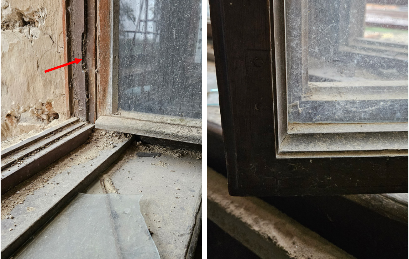
Slika 18. Detalj prozorskog krila s prethodne slike. Dodatni urez na doprozorniku (lijevo) je izveden za potrebe izvedbe inačice sa spojenim krilima. Profilacija krila i njihovo pozicioniranje pokazuje kako su za to vrijeme standardna vanjska krila bez posebne prilagodbe ovješena preko unutarnjih. Kasnije standardne inačice ovakvih prozora su odavale vizualni dojam današnjih prozora s IZO staklom.
