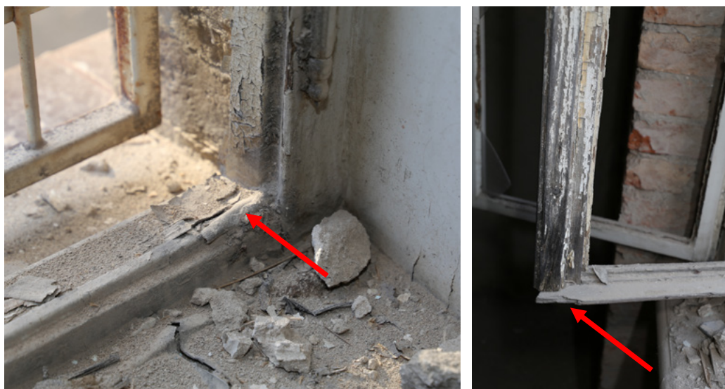
Slika 13, lijevo. Oštećenja boje desnog donjeg kuta doprozornika (crvena strelica), vidljiv je „S“ (zatični) prijelop vanjskoga krila s vertikalnim okvirnicama doprozornika. Potpuno je oljušten površinski zaštitni sloj i oštećena okvirnica vanjskog krila (desno).
