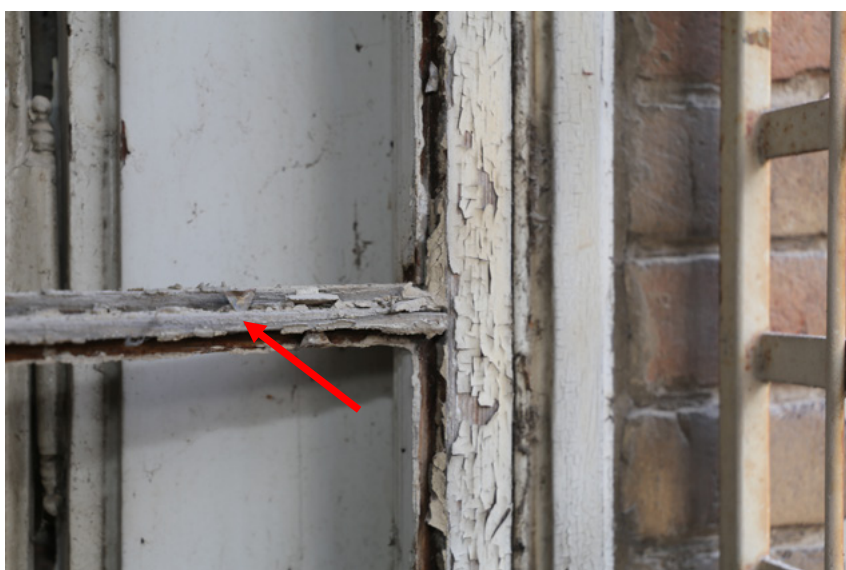
Slika 13, lijevo. Oštećenja boje desnog donjeg kuta doprozornika (crvena strelica), vidljiv je „S“ (zatični) prijelop vanjskoga krila s vertikalnim okvirnicama doprozornika. Potpuno je oljušten površinski zaštitni sloj i oštećena okvirnica vanjskog krila (desno).
