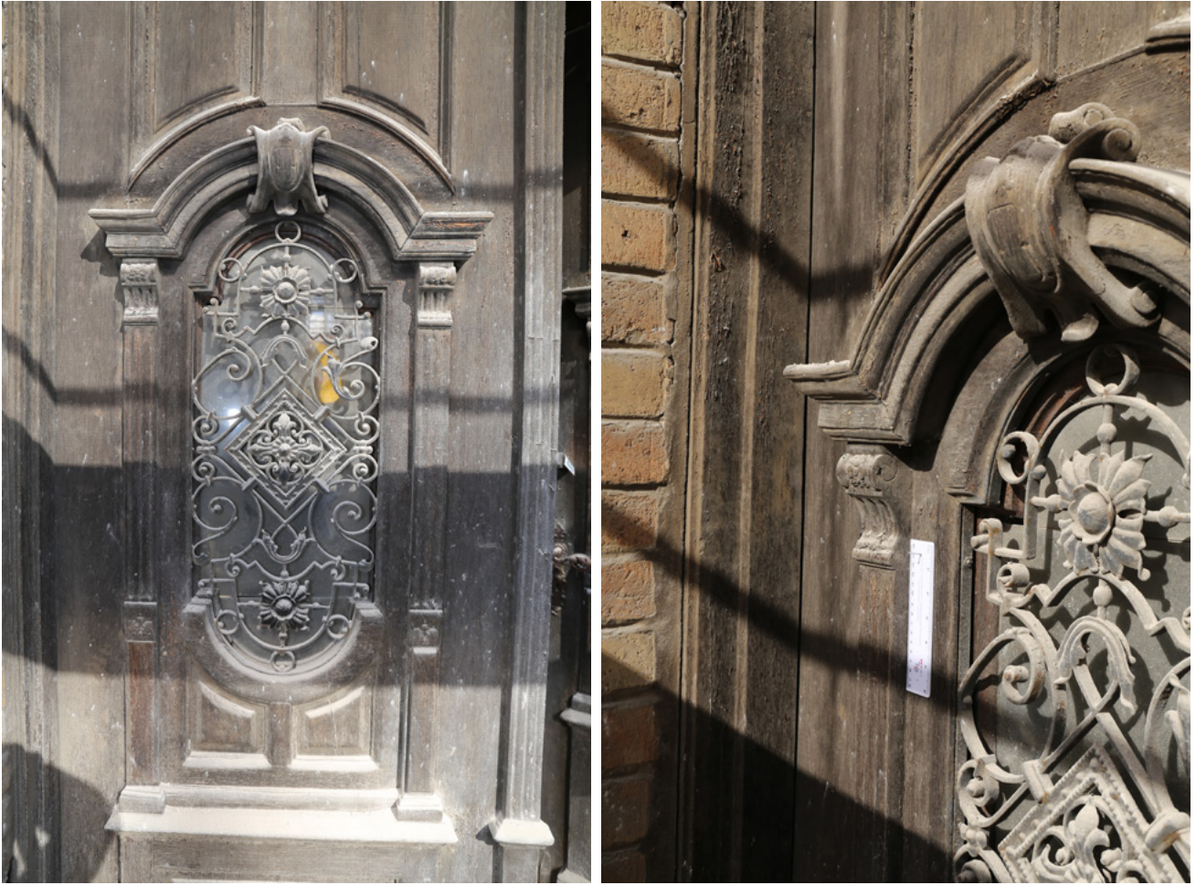
Slika 26. Detalj središnjeg dijela ulaznih vrata. Ostakljeno krilo je s vanjske strane nadstvođeno bogatim ukrasima koji su izvedeni od nekoliko segmenata te lijepljenjem i čavlima pričvršćeni za glavno krilo. Rešetka od kovanog željeza je upuštena u poluutor okvira krila.
