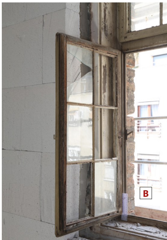
Slika 7 a i b. Pogled iznutra na tipičan prozor na zgradi Gliptoteke. Unutarnja krila već izostaju. Sva krila se otvaraju zaokretno, središnjom kvakom i zaobljenim šipkama. S unutarnje strane krila i doprozornici djeluju razmjerno dobro. Pogled na tipično krilo izvana (slika desno) ukazuje na loše stanje površine drva, potpuno erodirani sloj površinske zaštite, razbijena stakla u pojedinim oknima, te poispadali staklarski kit iz metalnih poluutora. Okapne letvice na donjem krilu na ovoj poziciji više nema.
