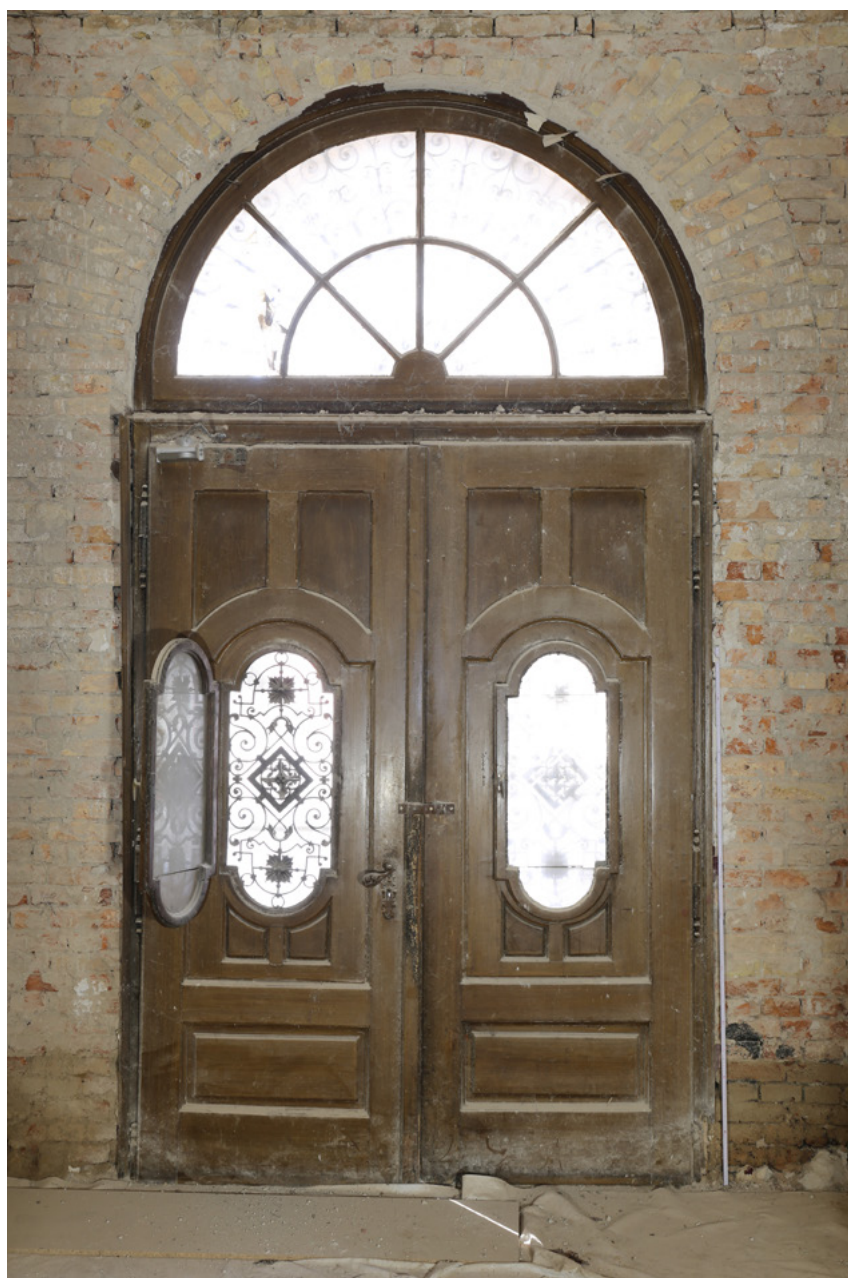
Slika 25. Pogled na ulazna vrata s unutarnje strane. Vrata su dvokrilna s lučnim nadsvjetlom i manjim zaobljenim ostakljenim krilima koja omogućuju provjetravanje i kada su vrata zatvorena. Glavno krilo je izviješeno i vitopero do mjere da ga je nemoguće zatvoriti; okviri prozorskih krila su razljepljeni i popucali.
