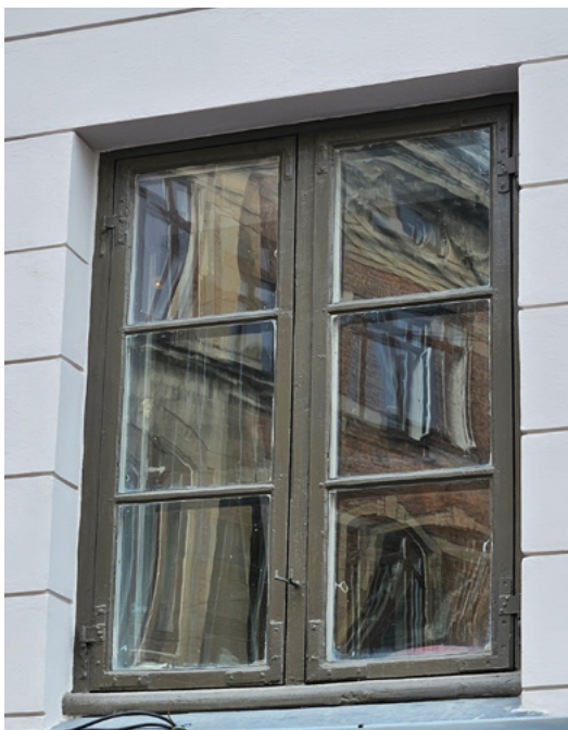
Slika 2a. Tipičan primjer prozora s dvostrukim krilima „tip Graz“ kod kojeg se vanjska krila otvaraju prema van s karakterističnim okovom za pričvršćenje u otvorenom stanju
