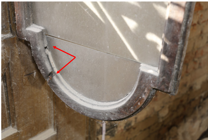
Slika 28. Unutarnje krilo je izvedeno kao dvoslojna konstrukcija; lijepljenje je provedeno sa zamakom tupih sučelja lučnih segmenata. Krila su ostakljena staklom iz 3 dijela koje je ugrađeno letvicama s unutarnje strane.
