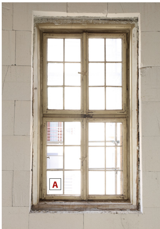
Slika 7 a i b. Pogled iznutra na tipičan prozor na zgradi Gliptoteke. Unutarnja krila već izostaju. Sva krila se otvaraju zaokretno, središnjom kvakom i zaobljenim šipkama. S unutarnje strane krila i doprozornici djeluju razmjerno dobro. Pogled na tipično krilo izvana (slika desno) ukazuje na loše stanje površine drva, potpuno erodirani sloj površinske zaštite, razbijena stakla u pojedinim oknima, te poispadali staklarski kit iz metalnih poluutora. Okapne letvice na donjem krilu na ovoj poziciji više nema.
