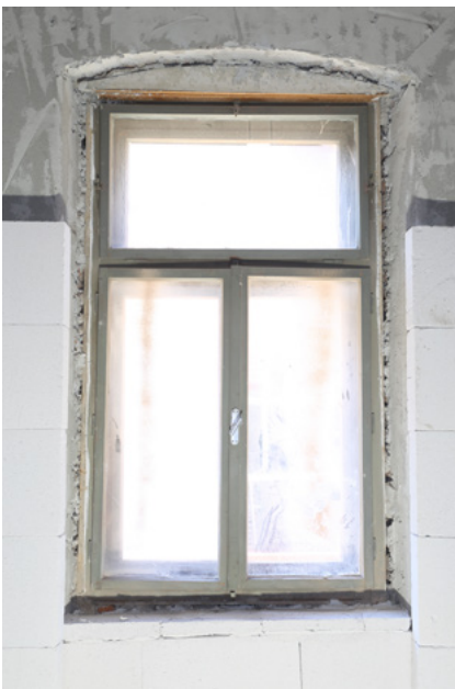
Slika 4. Tipičan primjer prozora s dvostrukim krilima „tip Beč“ kod kojeg se sva krila, uključujući otklopno nadsvjetlo, otvaraju prema unutra
