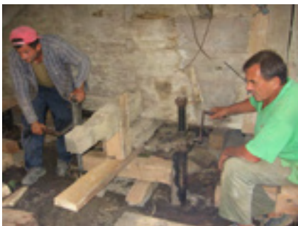
Podizanje stijenke kuće vintama (autodizalicom) pri niveliranju
