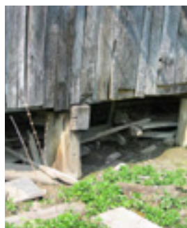
U starije vrijeme kao temelji u poplavnim krajevima služili su i hrastovi stupci („bapke“ – prežetak iz vremena sojenica)
