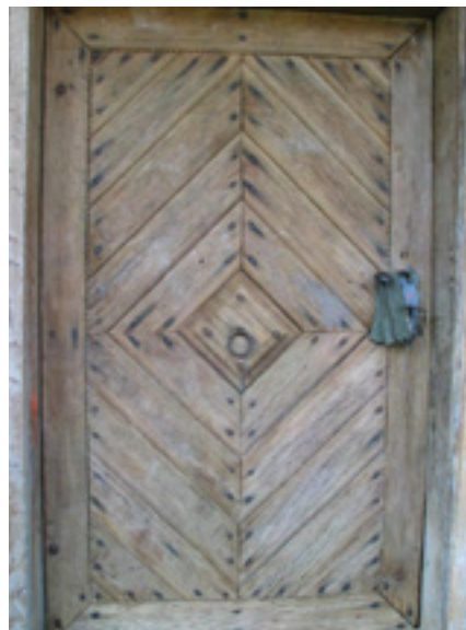
Tradicijska vrata od hrastovine s kovanim čavlima. Daščice postavljene dijagonalno iz kvadratičnog ishodišta.
