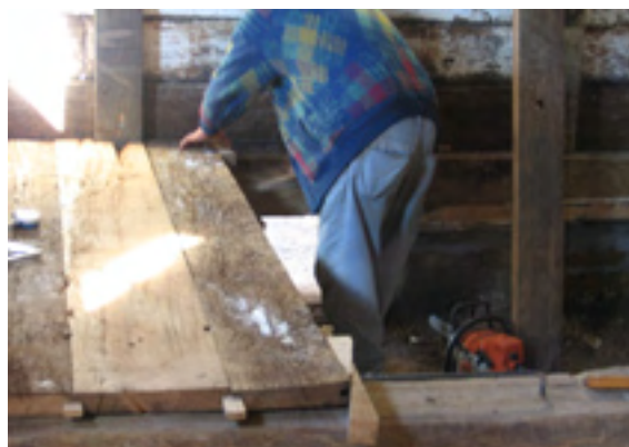
Rekonstrukcija poda prizemlja od planjki
