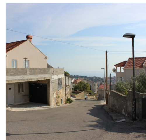
20.1 Naselje Nuncijata - izgrađeni dio
