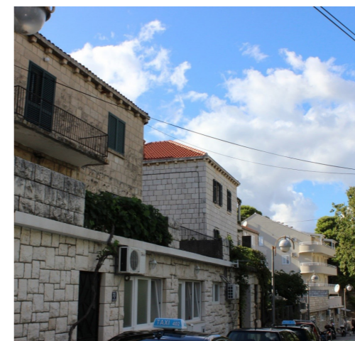
12.2 Moderni grad - stambena izgradnja uz Ulicu bana J. Jelačića
