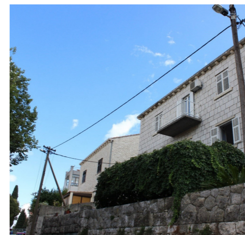
12.3 Moderni grad - stambena izgradnja uz Ulicu bana J. Jelačića
