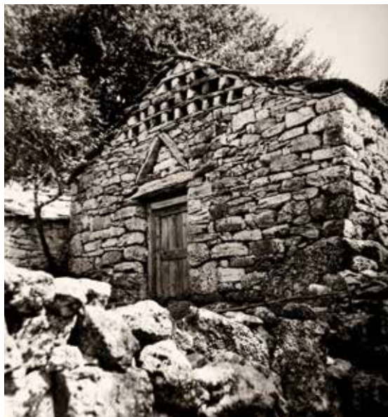
Veliki ogradni zid dvorišta (suhozid), s dračom na vrhu u Biovičinu Selu (gore), štala s golubarnicima u „somiću“ (dolje).
