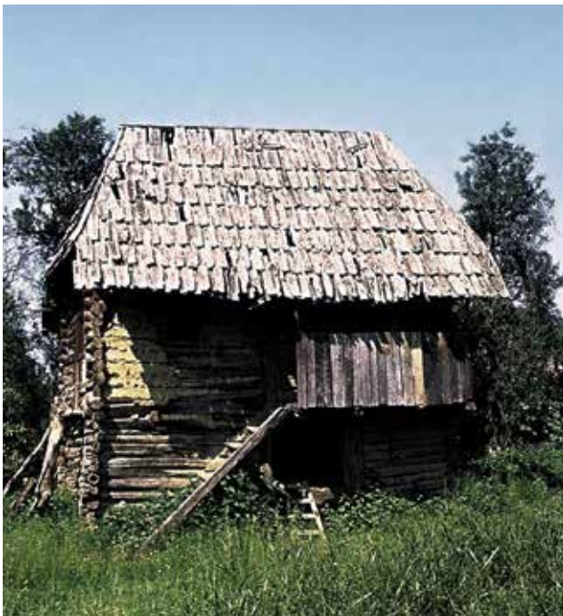
Još jedan tip zgradice s jednom ili dvijema sobicama (za mlade bračne parove) na katu i prizemljem koje je obično služilo kao spremište. Građena je brvnima s uglovima na preklop. Krov pokriven šindrom.
