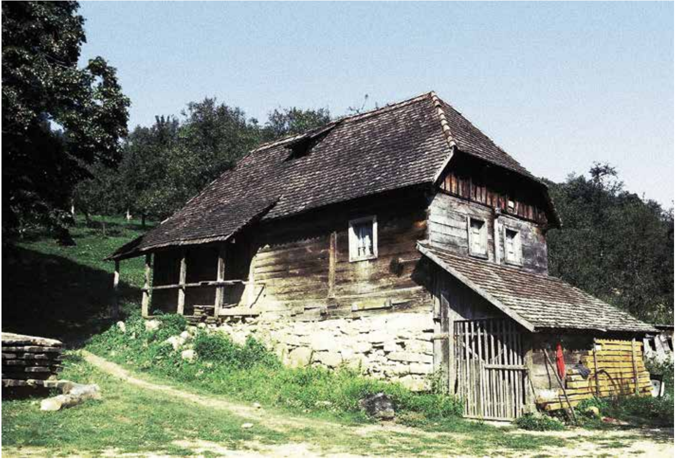
Nožinići (Dvor na Uni). Kuća s kamenom zidanim podrumom pod dijelom kuće (pod velikom sobom) i drvenim visokim prizemljem. Pred kuhinjom (prostorijom s ognjištem) dijelom uvučenim, a dijelom izbačenim natkrivenim trijemom. Na krovu pokrivenom biber crijepom otvor za izlazak dima.
