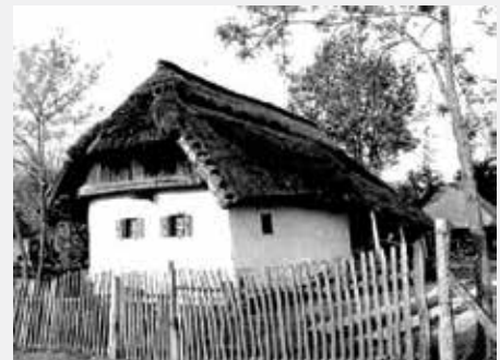
STARA BREZOVICA (VIROVITICA) Izvorno dvoprostorna kuća (kasnije pregrađena komora) s trijemom. Konstrukcija kanatna, pokrov slama.
