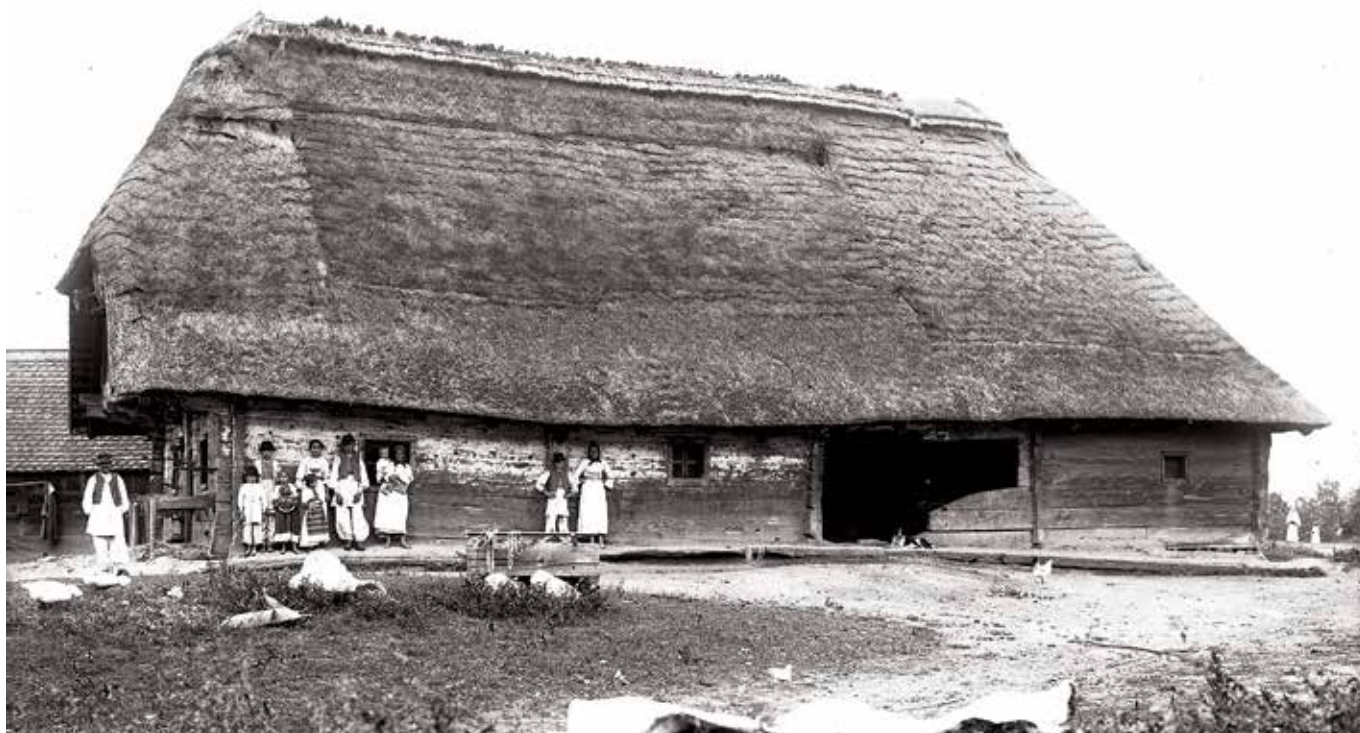
Zdenčina, velika kuća zadruge Milković, snimljeno 1922. god. (gore), stari turopoljski čardak s prizemljem od brvana i katom od tesanih planjki, pokriven šindrom. Na zabatu samo jedan mali prozor (dolje lijevo), štala u Mraclinu (dolje desno).
