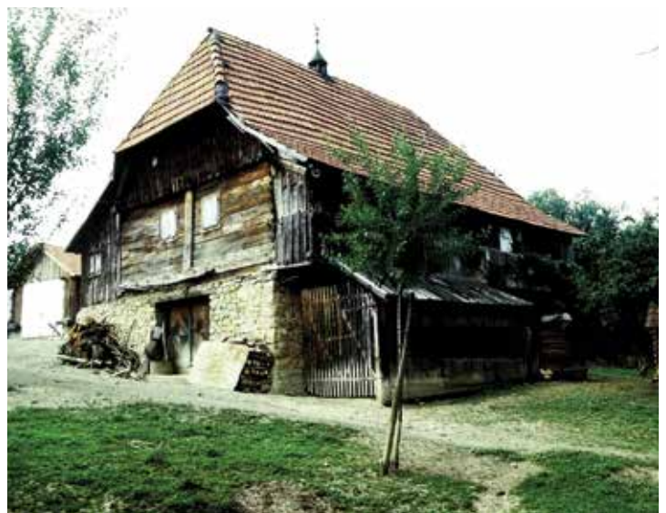
Kuća s kamenom zidanim podrumom i katom od planjki. Strmo krovšte pokriveno utorenim crijepom koje je izvorno očito bilo pokriveno šindrom. Na sljemenu limena badža.
