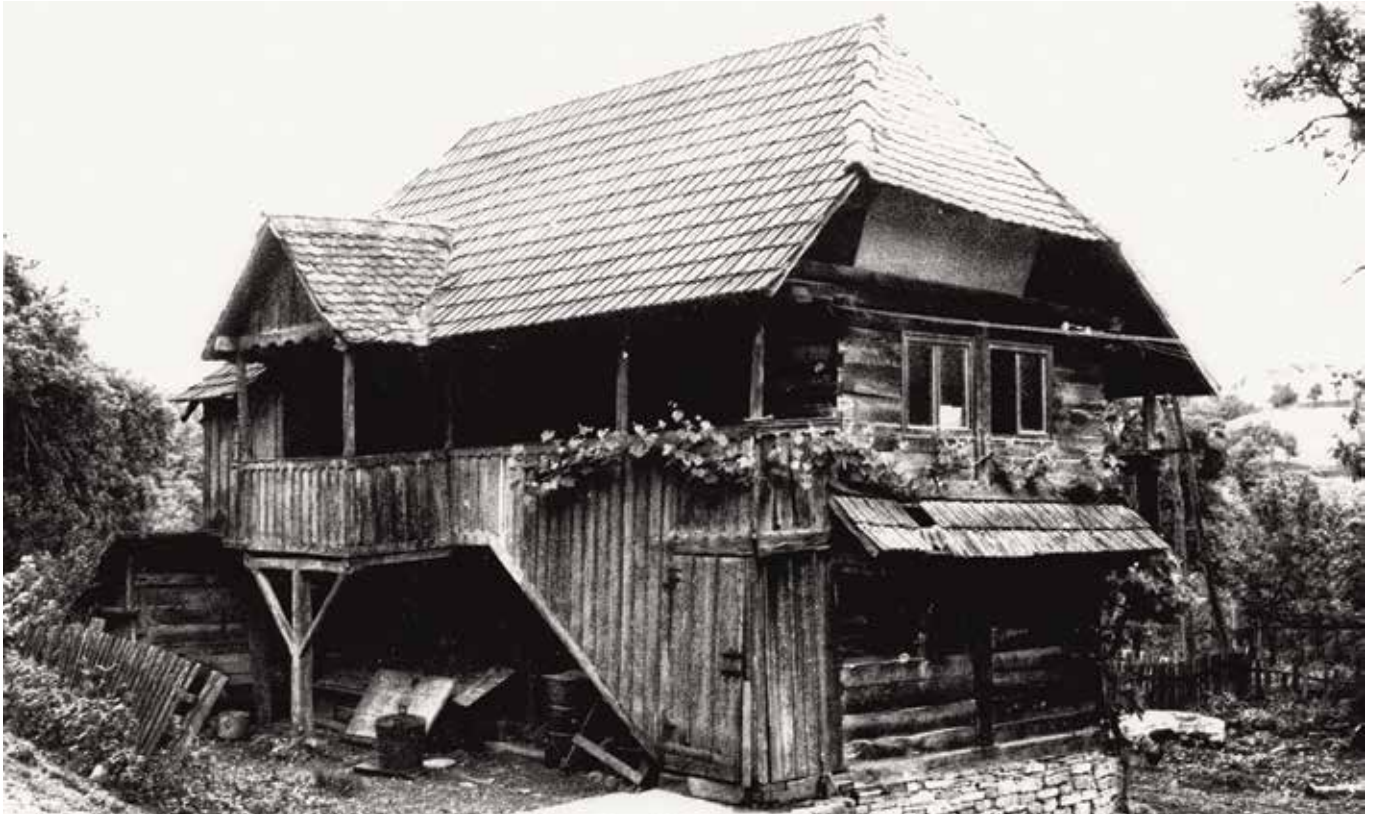
Ljeskovac (Glina). Drvena katnica na kamenom podzidu. Prošireni trijem pred ulazom na katu poduprt stupom s „rukama“, što je karakterističan motiv za ovo područje
