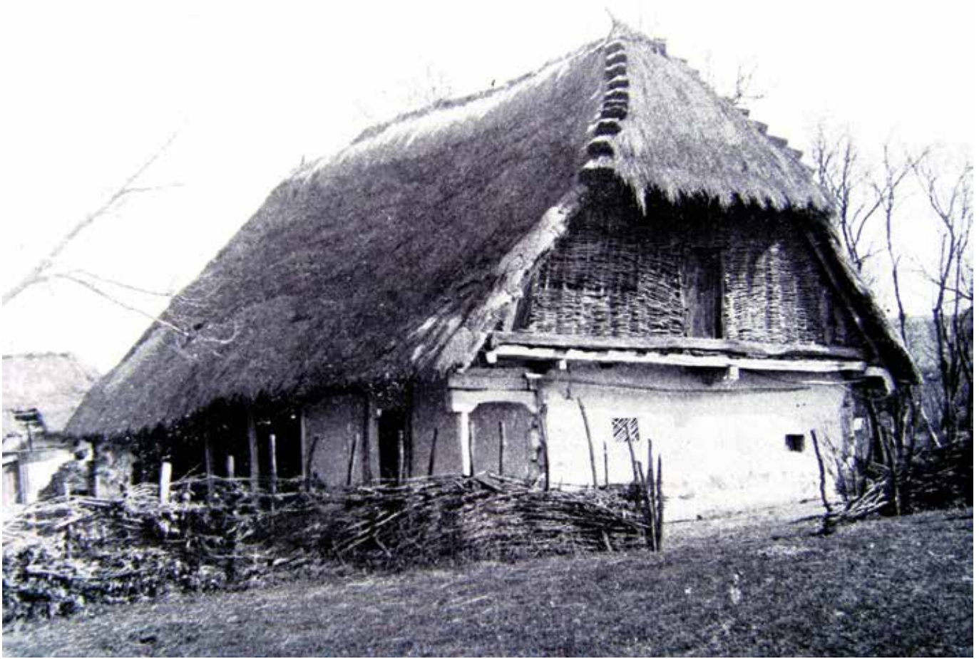
Stara podravska kuća u Črnčevcu (Sv. Petar Orehovec) građena od drva s trijemom ispred uzdužnog pročelja. Stijenka zabata od pletera.
