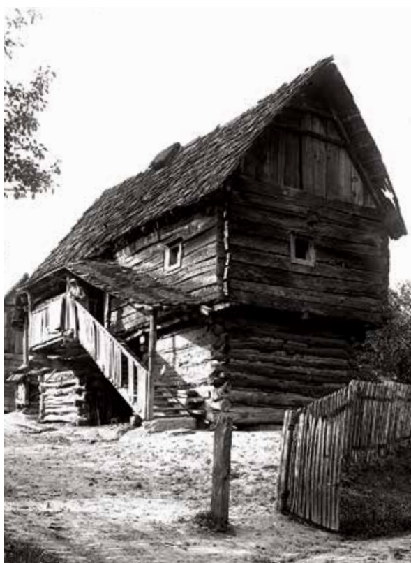
Zdenčina, velika kuća zadruge Milković, snimljeno 1922. god. (gore), stari turopoljski čardak s prizemljem od brvana i katom od tesanih planjki, pokriven šindrom. Na zabatu samo jedan mali prozor (dolje lijevo), štala u Mraclinu (dolje desno).
