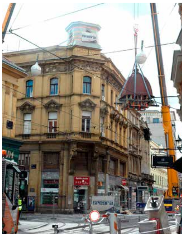
17 Demontaža kupole, 30. travnja 2020. (foto: P. Puhmajer)
