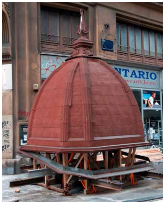
16 Demontirana kupola, travanj 2020. (foto: P. Puhmajer)
