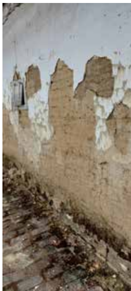
Fotografija zida gatora koji će se obnavljati starim tehnikama, srpanj 2023.
