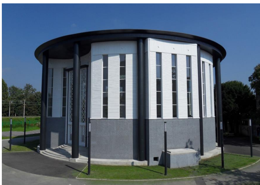
Slika 5.2 Pročelje paviljona nakon obnove.
