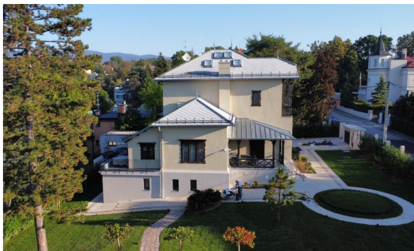
Slika 5.5 Južno pročelje ljetnikovca poslije obnove.
