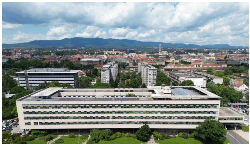
Slika 5.6 Fotonaponska elektrana na krovu zgrade Gradskog poglavarstva, Grad Zagreb.
