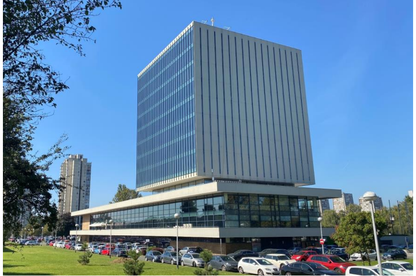
Slika 5.3 Sjeverno pročelje i prilazni plato nakon obnove.
