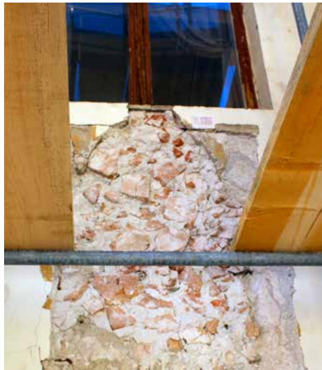
11 Mjesto lijevanog ukrasa na parapetu prozora drugog kata. Ukas je bio podržan željeznim kukama i opšiven grubom žbukom. Nakon skidanja aplikacije šupljina je zapunjena mortom i opekam, a u okolnoj žbuci sačuvane su kuke kojima je bila pričvršćena (foto: Z. Boban, 2017.).
