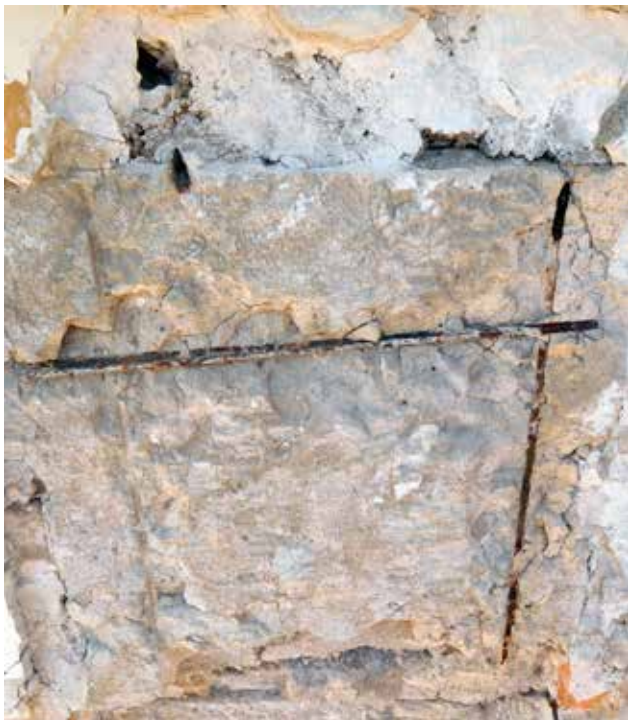
10 Pravokutna betonska kasetna armirana željeznim šipkama – poledina (nosilac) otučenog lijevanog ukrasa na frizu (foto: S. Buble, 2017.)
