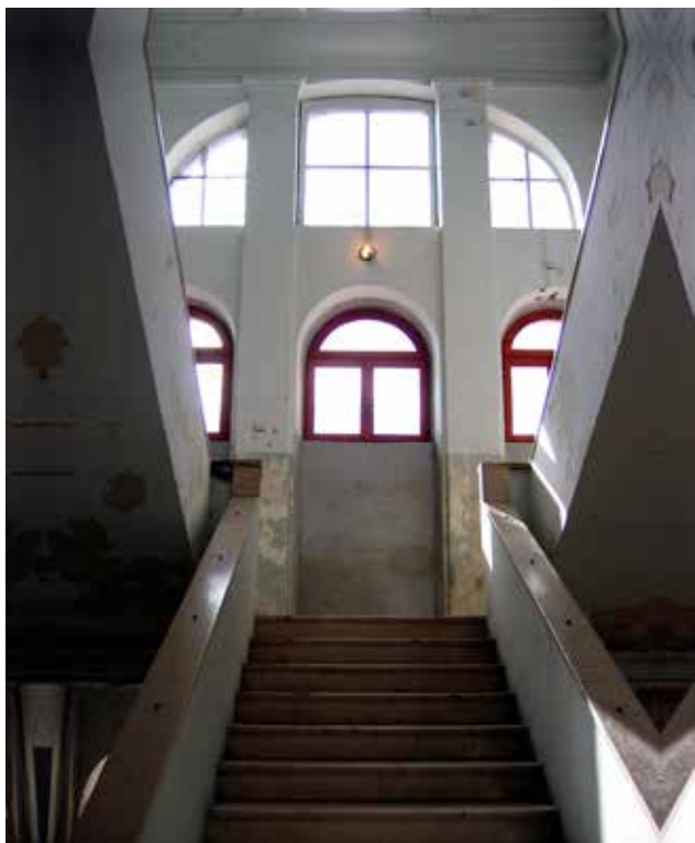
13 Trokrako stubište, podest na prilazu trećem katu. U preuređenju 1947. – 1948. godine profilirani bočni rubovi stuba su otučeni, a izvorna željezna stubišna ograda zamijenjena je punom ogradom od opeke (foto: S. Buble, 2009.).
