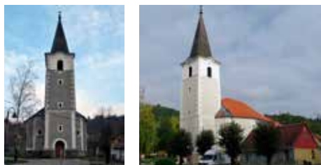
22, 23 Lobor, Župna crkva sv. Ane, pogled na glavno pročelje prije obnove 2011. i nakon obnove 2015. (fototeka KOKR). Vrsta boje, proizvođač: silikatna, Samoborka. Godina obnove: 2015.
