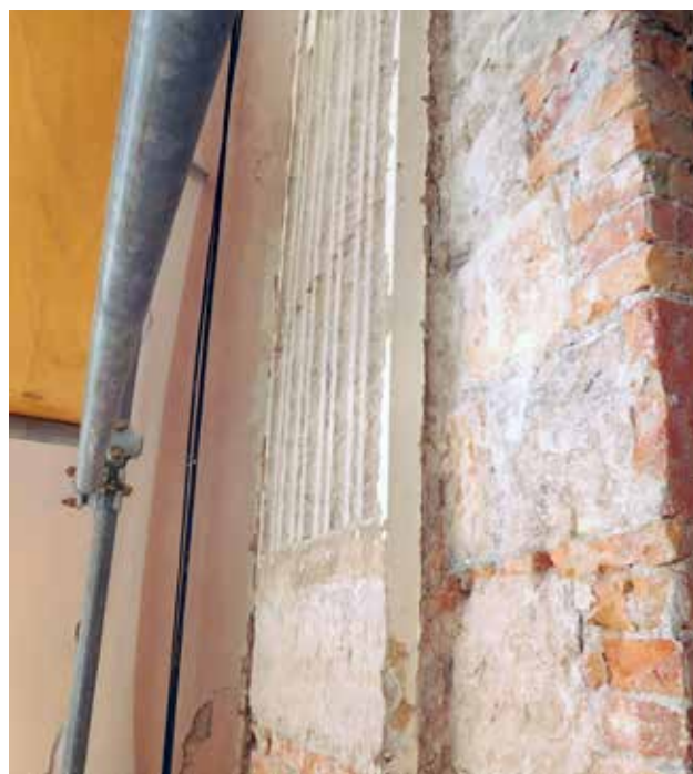
12 Donji dio pilastra otkriven pod recentnim slojem žbuke; baza modelirana na istaknutim redovima opeke je otučena (foto: S. Buble, 2019.).
