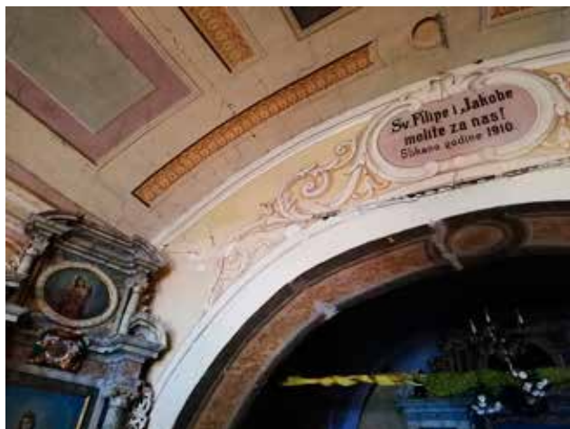
10 Crkva sv. Filipa i Jakova u Reštovu, oštećenja trijumfalnog luka (foto: B. Križanić, KO KA, 2021.)
