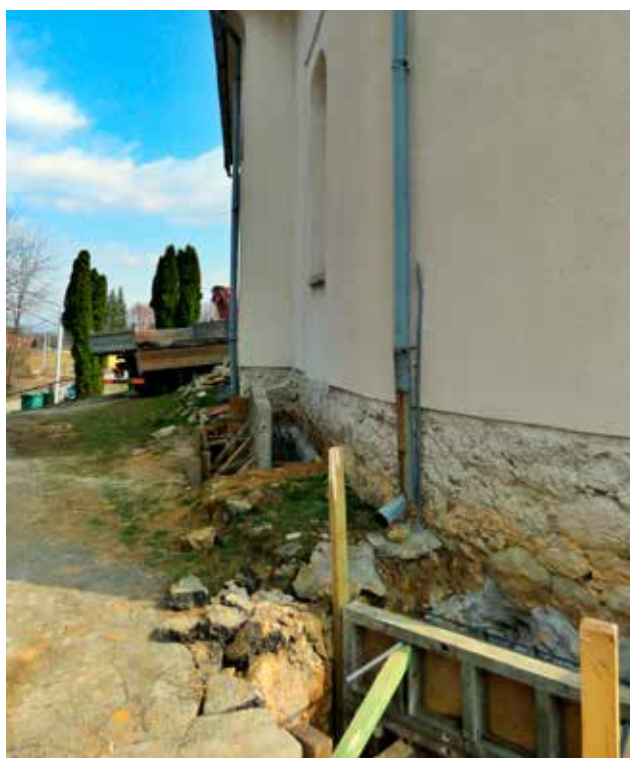
4 Crkva sv. Ivana Krstitelja u Svetičkom Hrašću, kampadna konsolidacija kamenog temelja (foto: S. Kočevar, KO ZG, 2022.)
