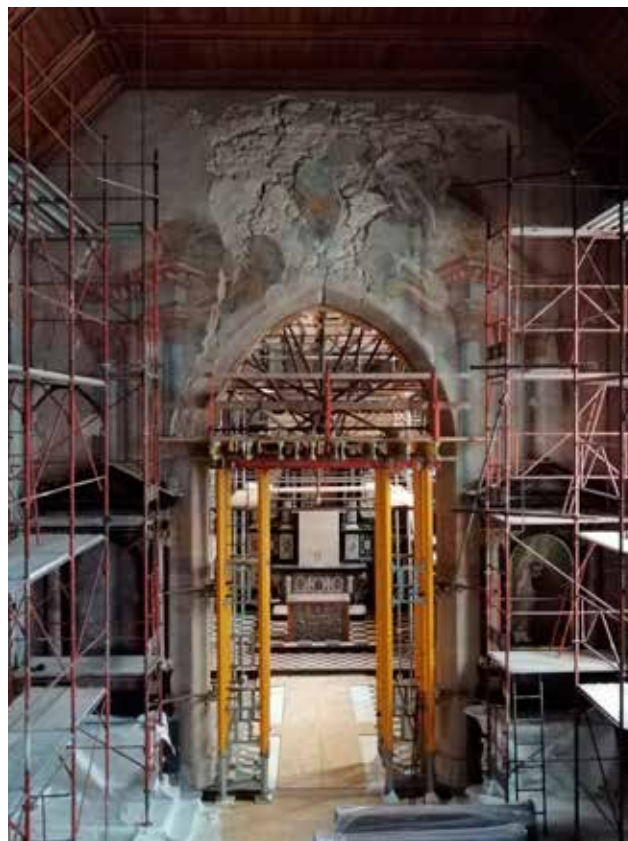
13 Podupiranje trijumfalnog luka u crkvi Uznesenja Blažene Djevice Marije u Remetama (fototeka GZZSKP, 2020.)
