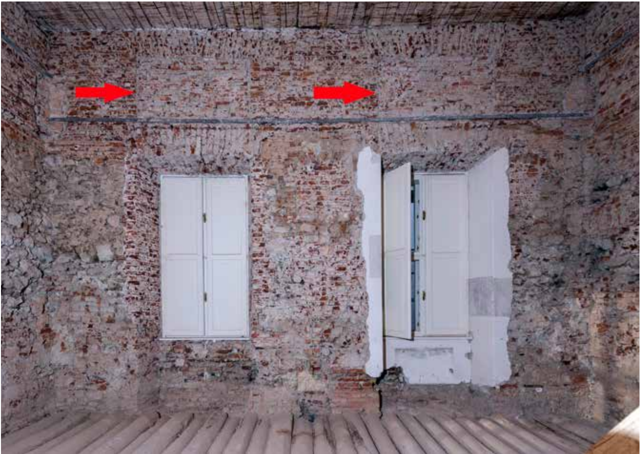
7 Palača Pongratz, središnja prostorija drugog kata u „kuli“ nakon obijanja žbuke, vidljivi manji zazidani prozori iznad postojećih (foto: G. Tomljenović, HRZ, 2023.)
