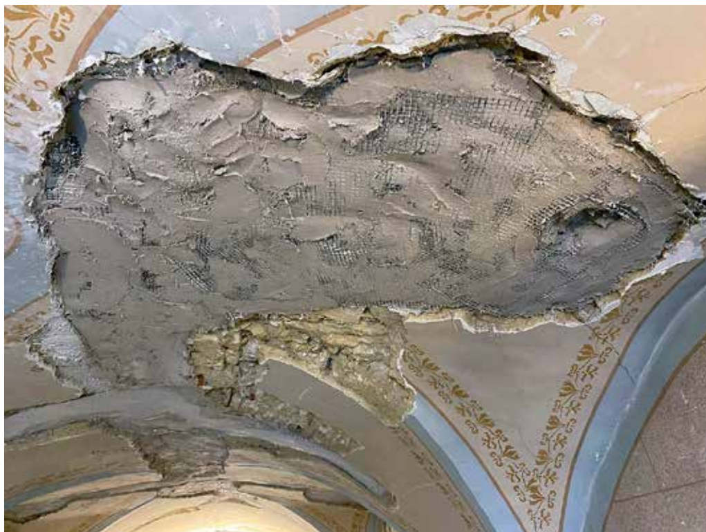
5 Maruševec, crkva sv. Jurja mč., sanacija oštećenja primjenom FRCM sustava (foto: V. Pascuttini-Juraga, KO VŽ, 2021.)
