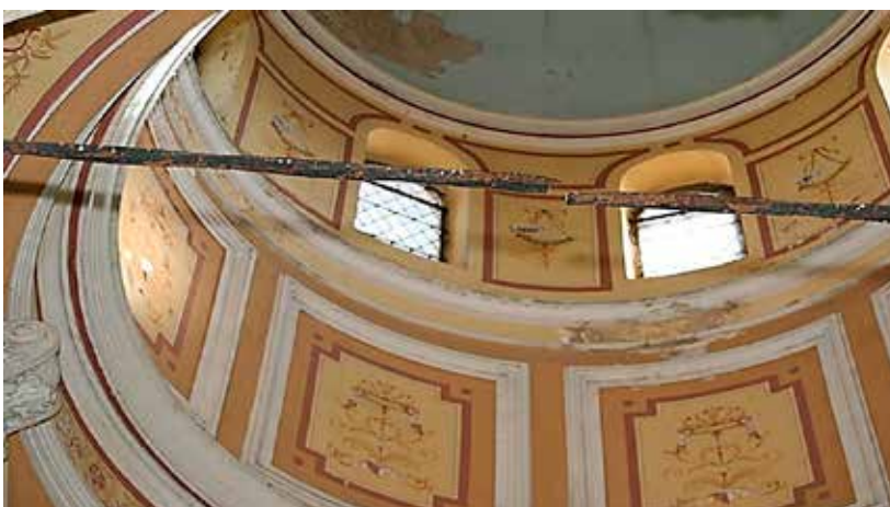
Pogled na oštećenja svodova i lukova malih i velikih arkada (gore) i puknuće zatege južnih arkada (dolje)
