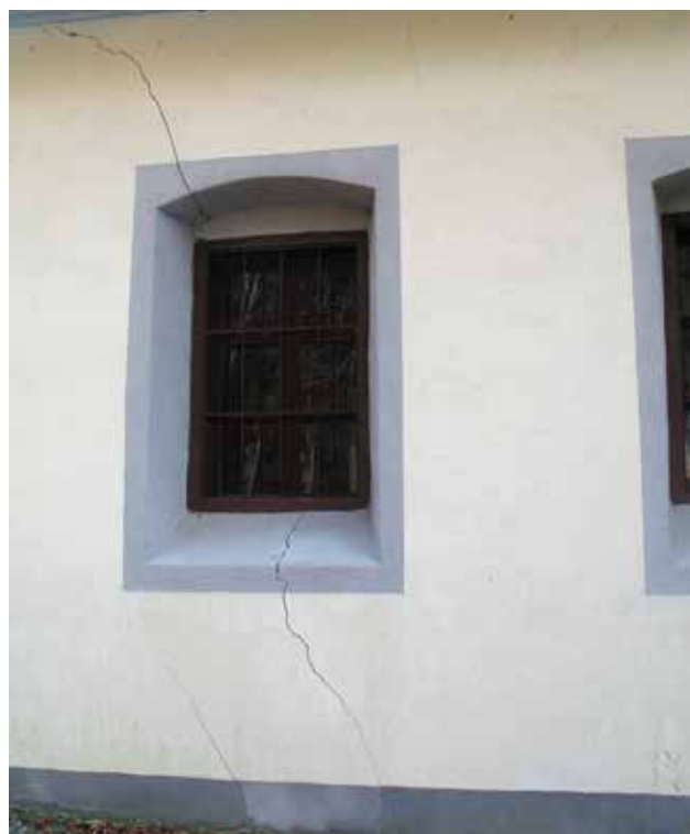
5 Kapela sv. Leonarda u Donjem Prilišću, pukotina poprečno na uzdužne zidove (foto: B. Križanić, KO KA, 2021.)
