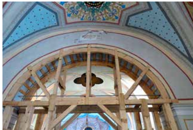
8 Crkva Majke Božje Snježne na Dubovcu, drveni podupirači i zatega u trijumfalnom luku (foto: S. Kočevar, KO KA, 2022.)
