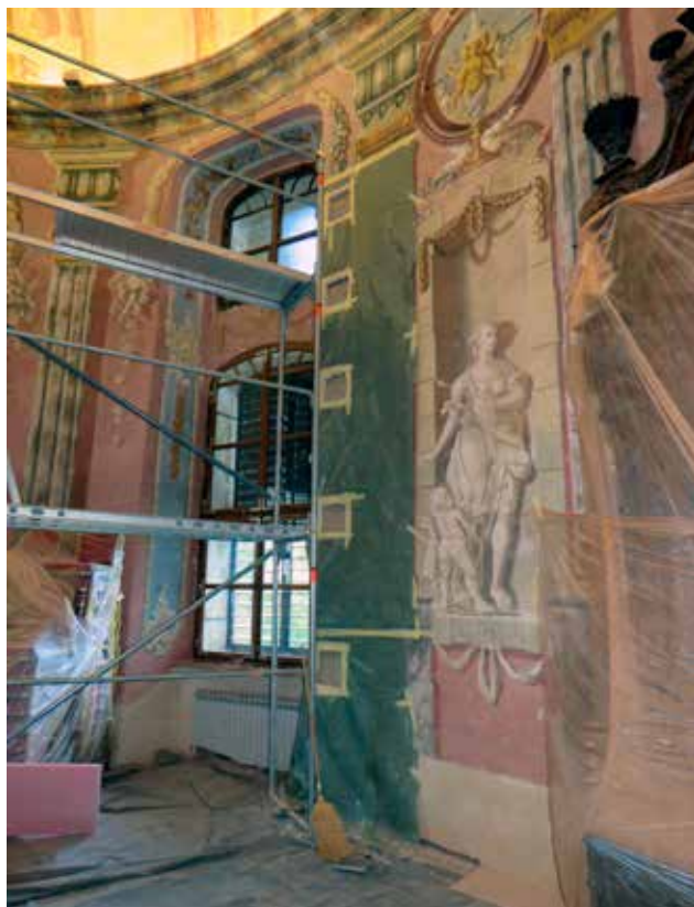
8 Gornja Bistra, dvorac Oršić, ovalna dvorana, oznake za bušenje zida s oslikom (foto: V. Jakaša Borić, KO ZG, 2022.)
