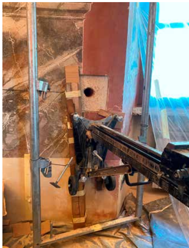
9 Gornja Bistra, dvorac Oršić, stroj kojim se izvodilo bušenje zidova u ovalnoj dvorani (foto: V. Jakaša Borić, KO ZG, 2022.)
