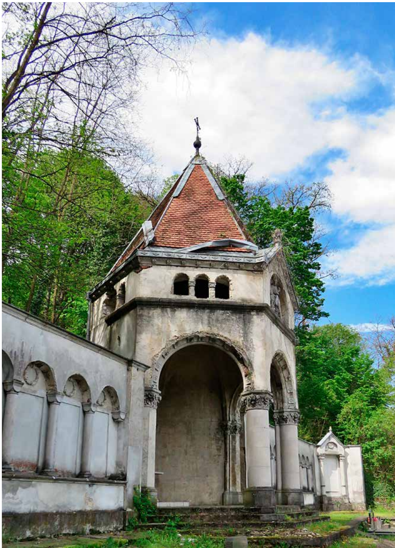
9 Spomenik Glorijeta na Vojnom groblju Dubovac, oštećenja pokrova i limarije (foto: S. Kočevar, KO KA, 2021.)
