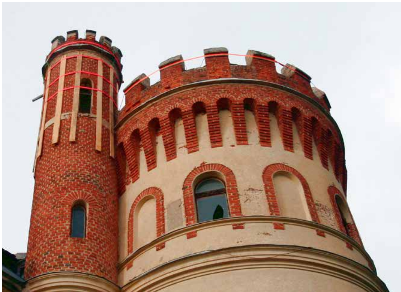
10 Dioš, dvorac Dioš, hitne mjere zaštite stubišnog rizalita i sjeveroistočne kule zatezanjem (foto: M. Pezelj, KO BJ, 2022.)
