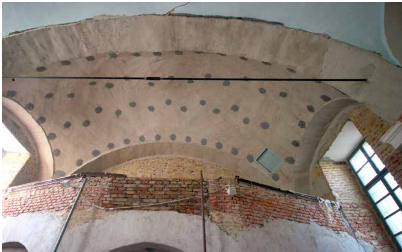
14 Gušćerovec, crkva sv. Antuna i ostaci kaštela, konstrukcijsko ojačanje svodnog polja kora (foto: M. Pezelj, KO BJ, 2021.)
