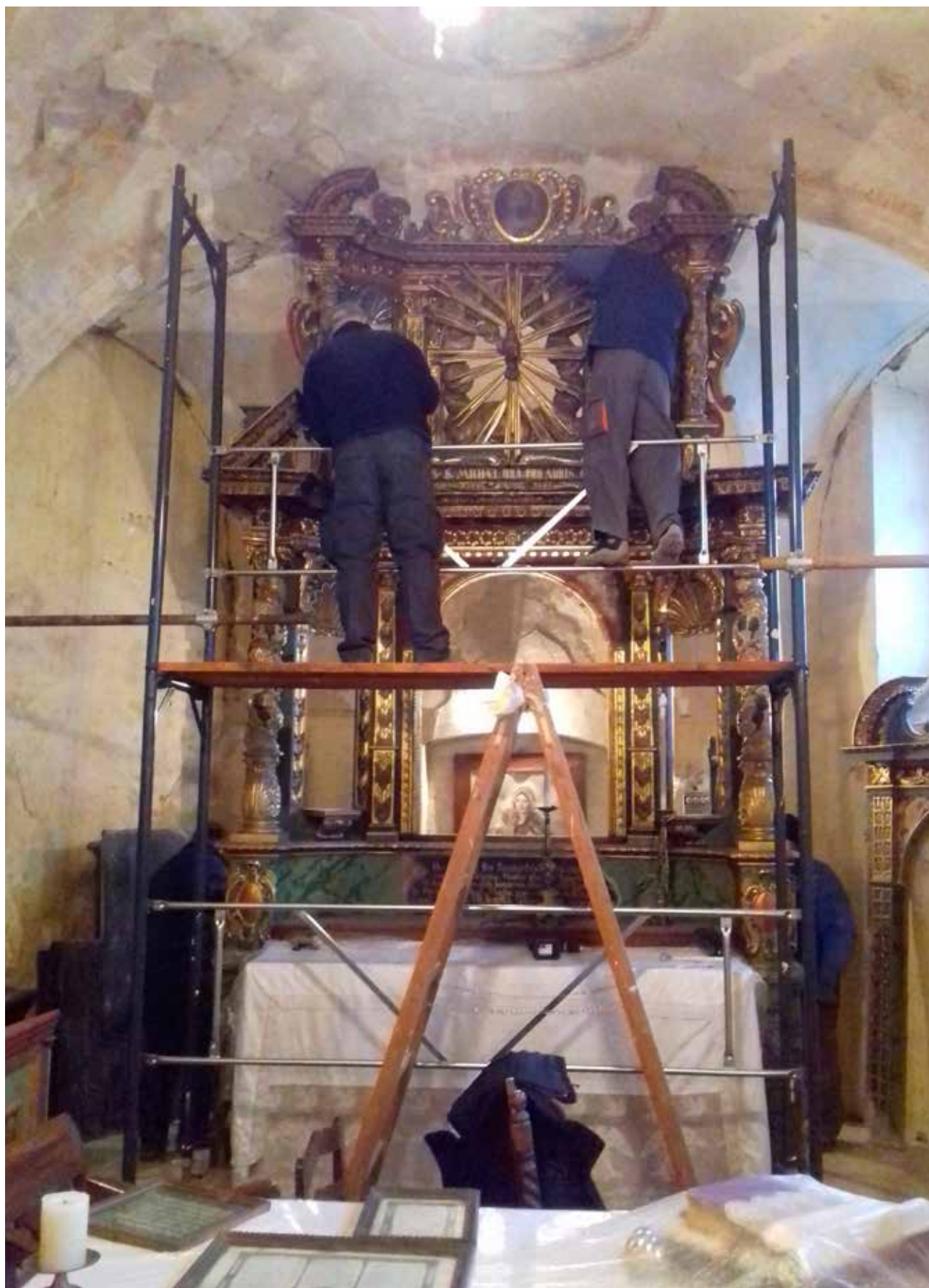
21 Demontaža atike glavnog oltara u kapeli sv. Mihalja u Vugrovcu (fototeka GZZSKP, 2020.)
