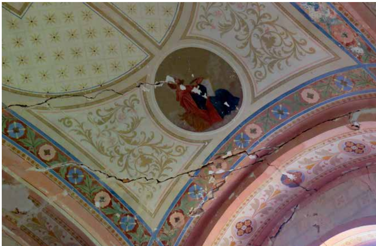
3 Crkva sv. Katarine u Kunićima Ribničkim, oštećenje svodnih polja (foto: S. Kočevar, KO KA, 2021.)
