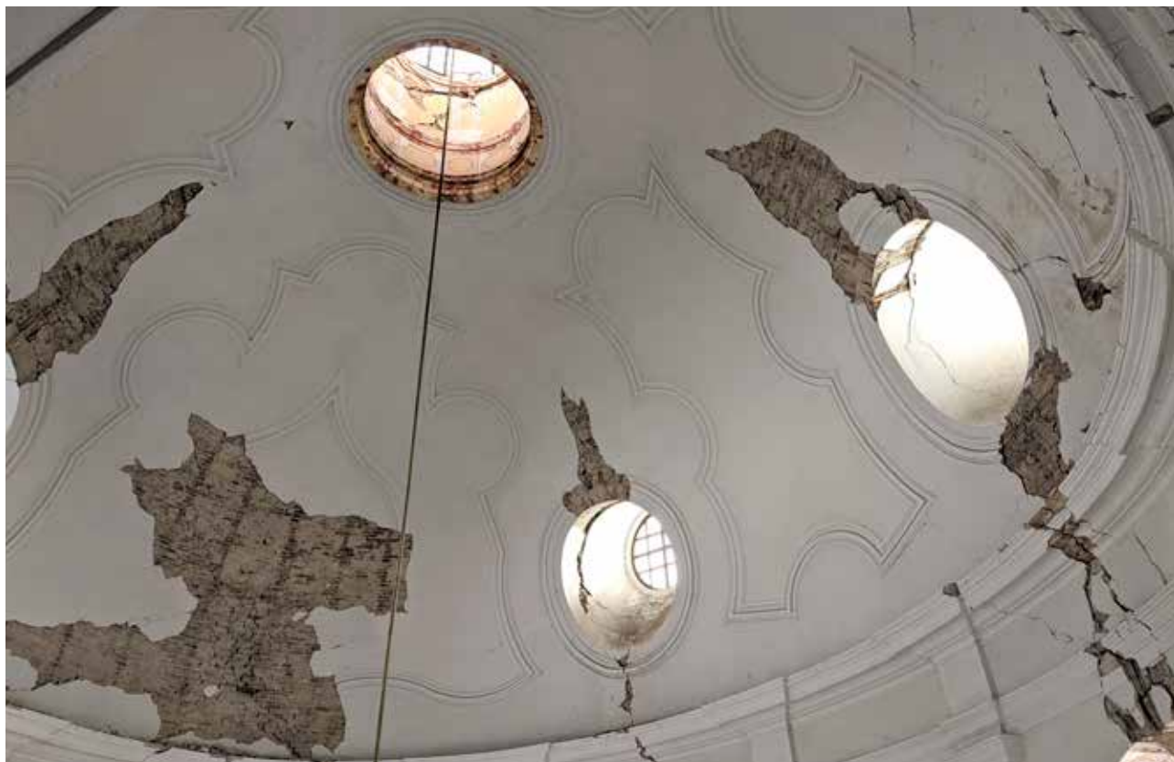
7 Crkva sv. Marije Magdalene u Selima, oštećenja štukature na svodu kupole nakon potresa (foto: G. Tomljenović, fototeka HRZ, 2021.)
