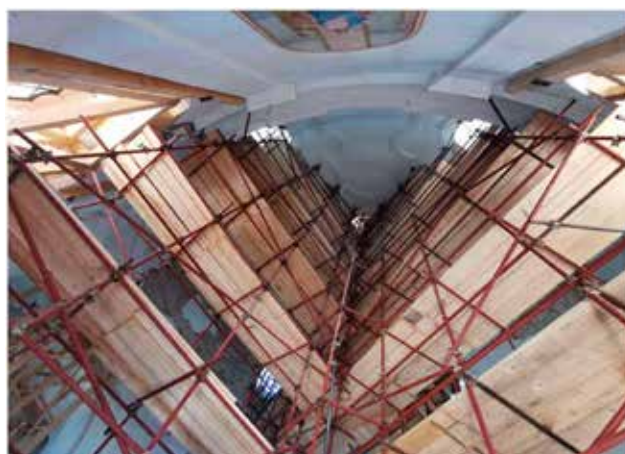
9. Crkva sv. Marije Magdalene u Selima, izvedene mjere privremene zaštite i stabilizacije – poduporna skela u lađi (foto: M. Vujasinović, Intrados projekt d.o.o., 2022.)
