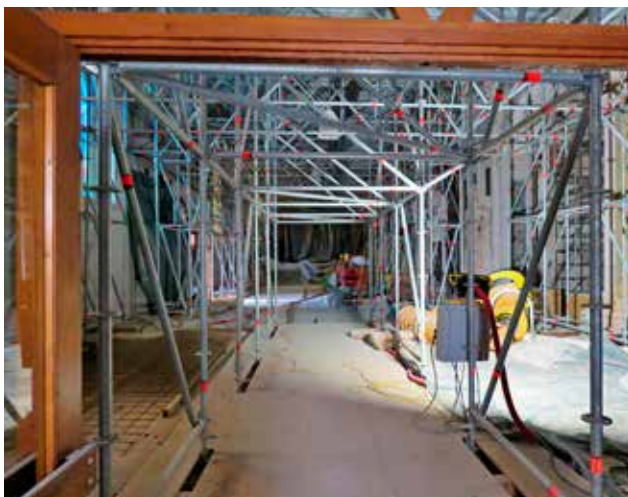
1 Crkva Presvetog Trojstva s franjevačkim samostanom u Karlovcu, teška skela u lađi crkve (foto: S. Kočevan, konzervatorski odjel u Karlovcu - dalje KO KA, 2021.)
