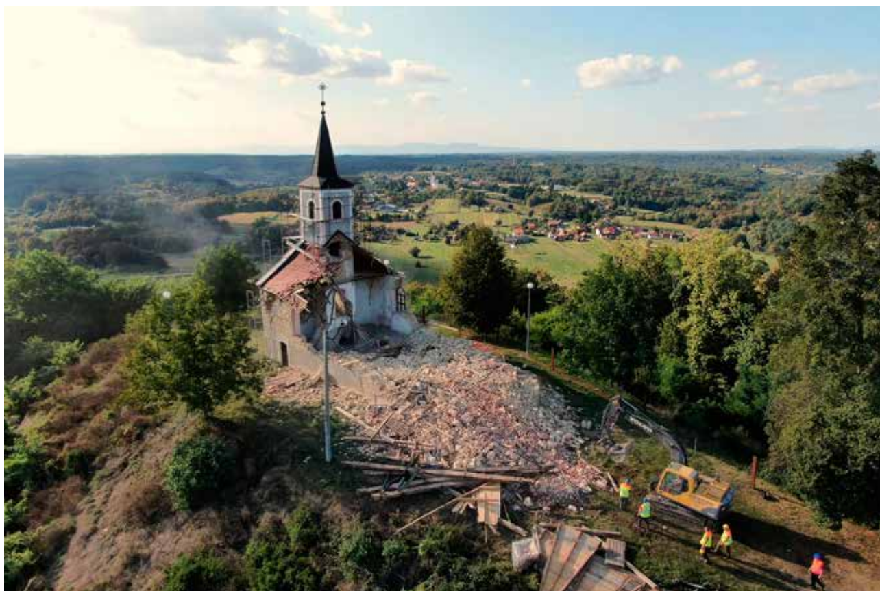
14 Kapela Presvetog Trojstva, razgradnja kapele, rujan 2021. ( https://www.radio-banovina.hr )
