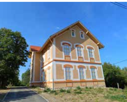
Obnovljena zgrada stare škole u Poljanici Bistranskoj, svibanj 2024.
