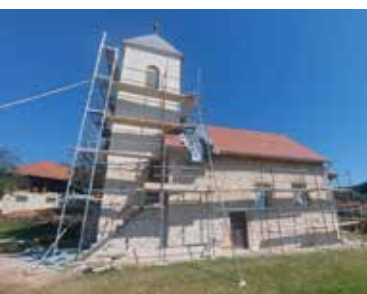
Vinično, kapela sv. Marije Magdalene, radovi na obnovi u tijeku
