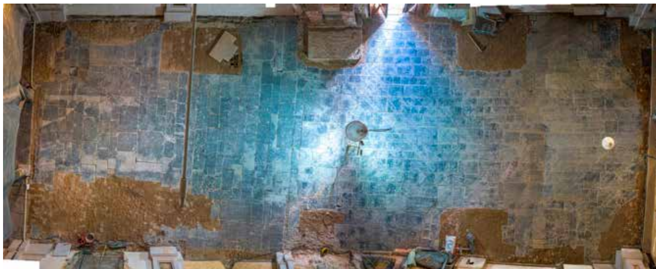
18 Lađa crkve Presvetog Trojstva, pogled na kameno popločenje lađe s vidljivim pozicijama nekadašnjih oltara (foto: Digitalni Tisak d.o.o.; montaža: A. Popovački, POP-AP d.o.o., 2023.)
