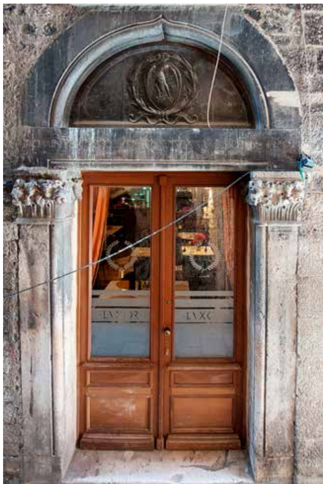
2 Nikola Firentinac-Andrija Aleši i kamenarska radionica, portal palače Cipci, između 1466-1474. godine. (foto: B. Pavazza, 2023.)
