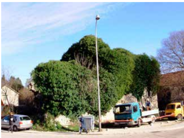
2 Izgled sklopa Serdarovih kuća 2007. godine prije početka sanacije (foto: I. Alduk, fototeka KO Imotski, 2007.)
