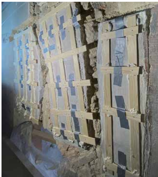
13 Čvrsti nosilac facinga na naslikanom medaljonu iznad nadvoja prozora na zapadnom zidu (foto: Katarina Gavrilica, HRZ, 2023.)
