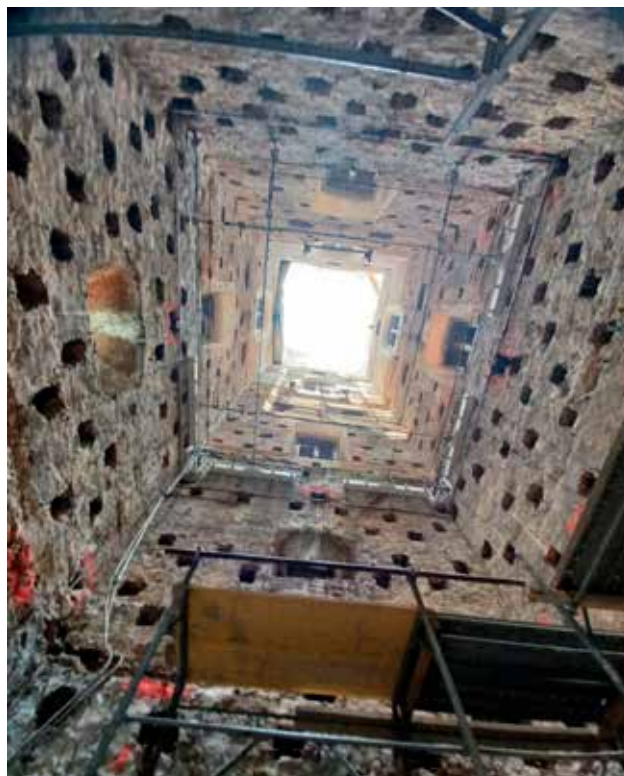
3 Pripremni radovi izvođenja AB obloge unutar zvonika (foto: S. Kočevar, KO KA, 2023.)
