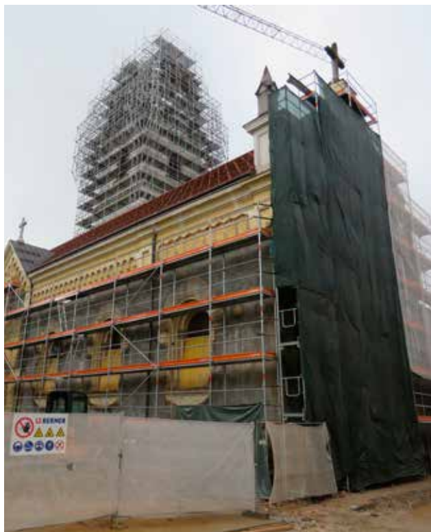
2 Radovi pojačavanja vanjskih zidova crkve (foto: S. Kočevar, KO KA, 2023.)
