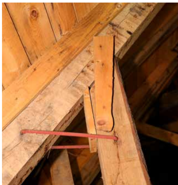
8 a i b. Na mjestima oštećenja krovišta bombardiranjem načinjeni su zahvati potpuno neadekvatne sanacije, kako s povijesno-tehničkog stajališta, tako i s aspekta zahtjeva pravilne tesarke tehnike i kvalitete izrade. Vidljiva su privremena podupiranja, neispravno izvedeni spojevi i pruručno osiguranje skobama i metalnim vezicama. Projektom sanacije ovakve elemente treba zamijeniti, a dijelove krova obnoviti adekvatnim drvenim dijelovima i spojevima (foto: H. Turkulin, 2021.)
