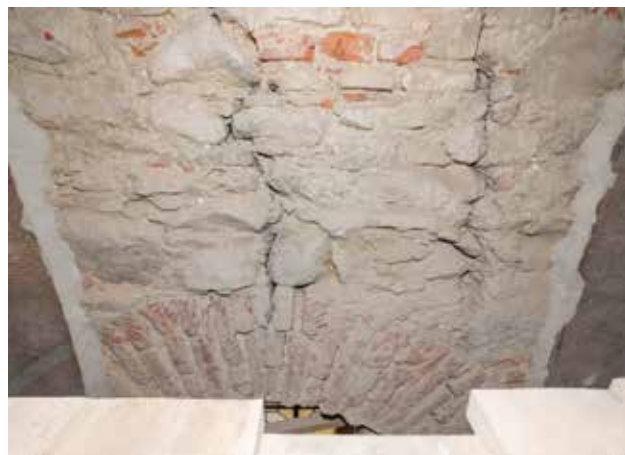
14 Zid iznad nadvoja prozora nakon transfera (foto: Katarina Gavrilica, HRZ, 2023.)
