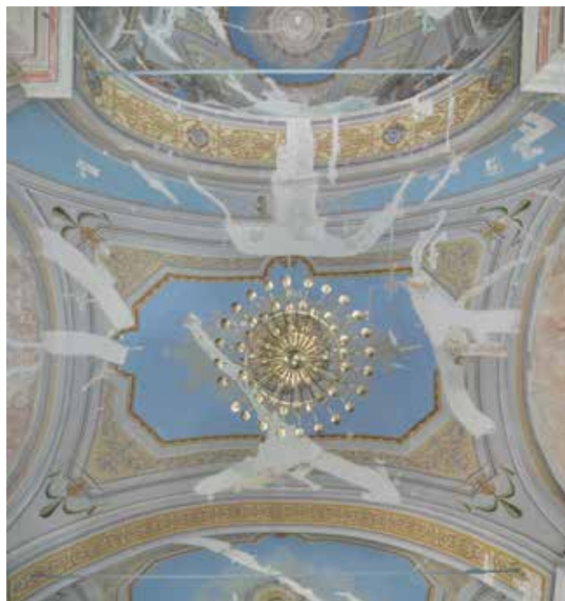
19 Istočni svod i slavoluk nakon završenih radova (foto: Katarina Gavrilica, HRZ, 2023.)
