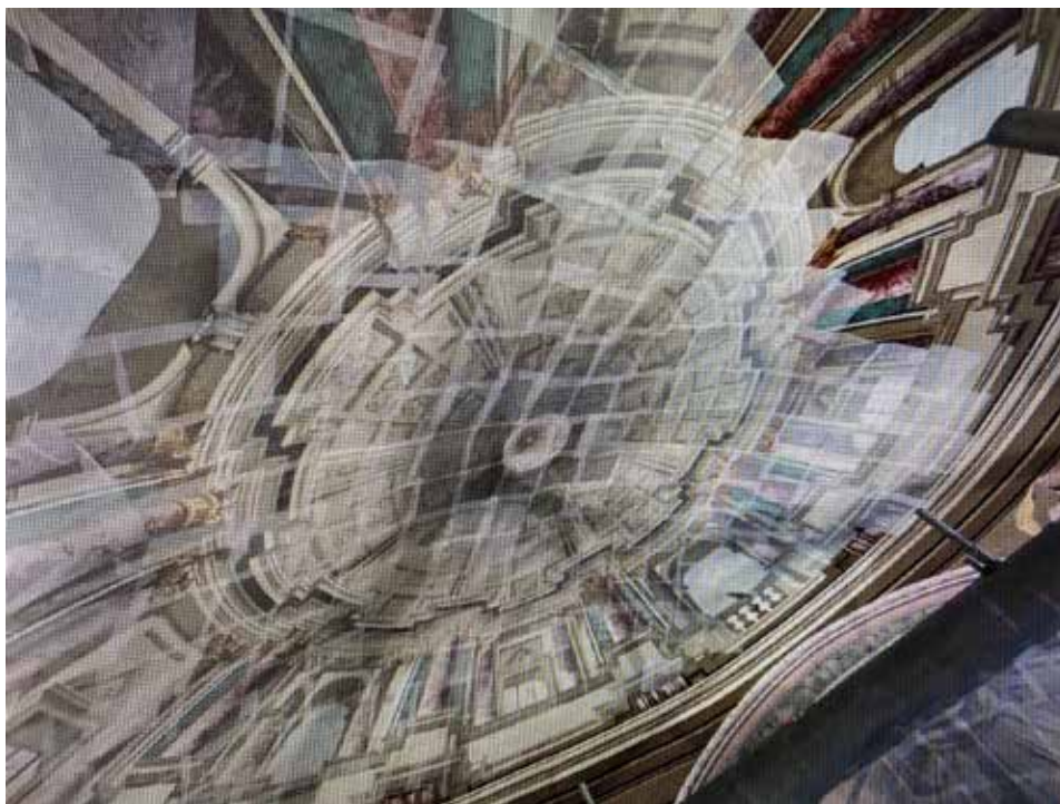
2 Samci (Gornja Stubica), dvorac Oršić, svodni oslik dvorske kapele zaštićen japan papirom tijekom radova (foto: V. Jakaša Borić, KO KR, 2023.)
