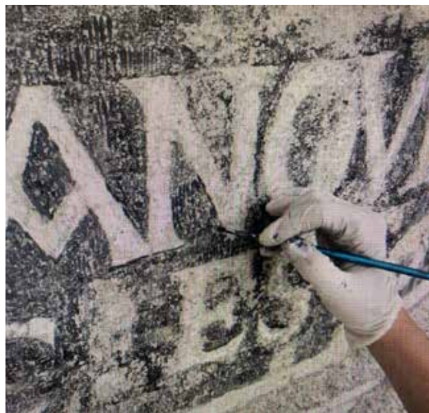
4 Hrašćina, župna crkva sv. Nikole, očuvani fragment baroknog zidnog oslika na zvoniku, izvođenje završnog retuša tehnikom trateggio nakon radova konstrukcijske sanacije (foto: D. Jurčić, Art4art d.o.o., 2023.)
