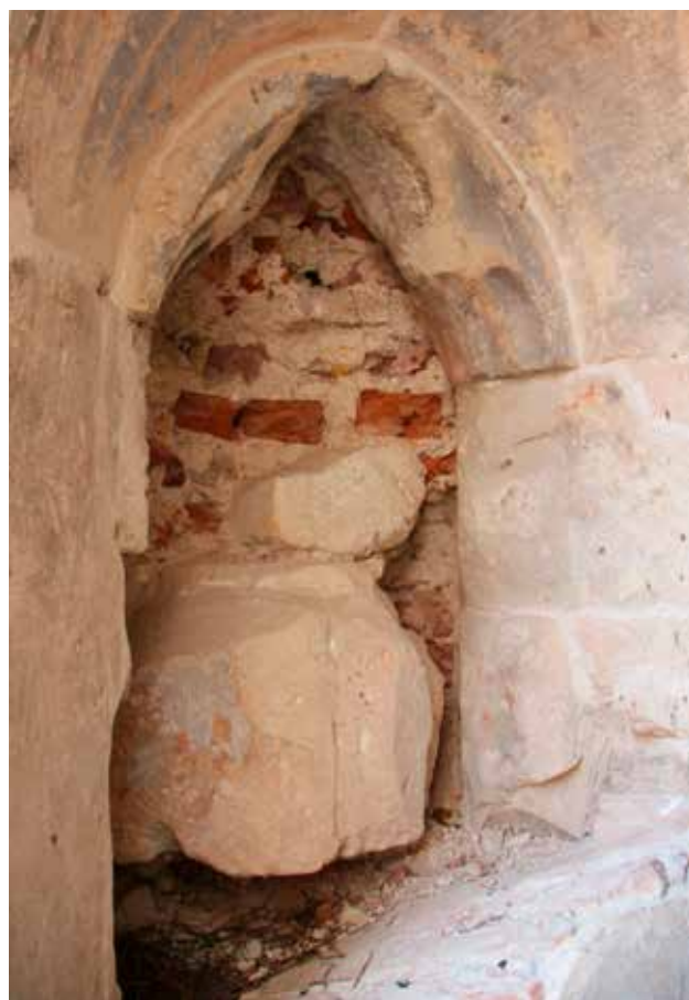
13 Ostaci kasnogotičke monofore na jugoistočnom zidu poligonalnog zaključka svetišta (foto: D. Podunavac, 2018.)
