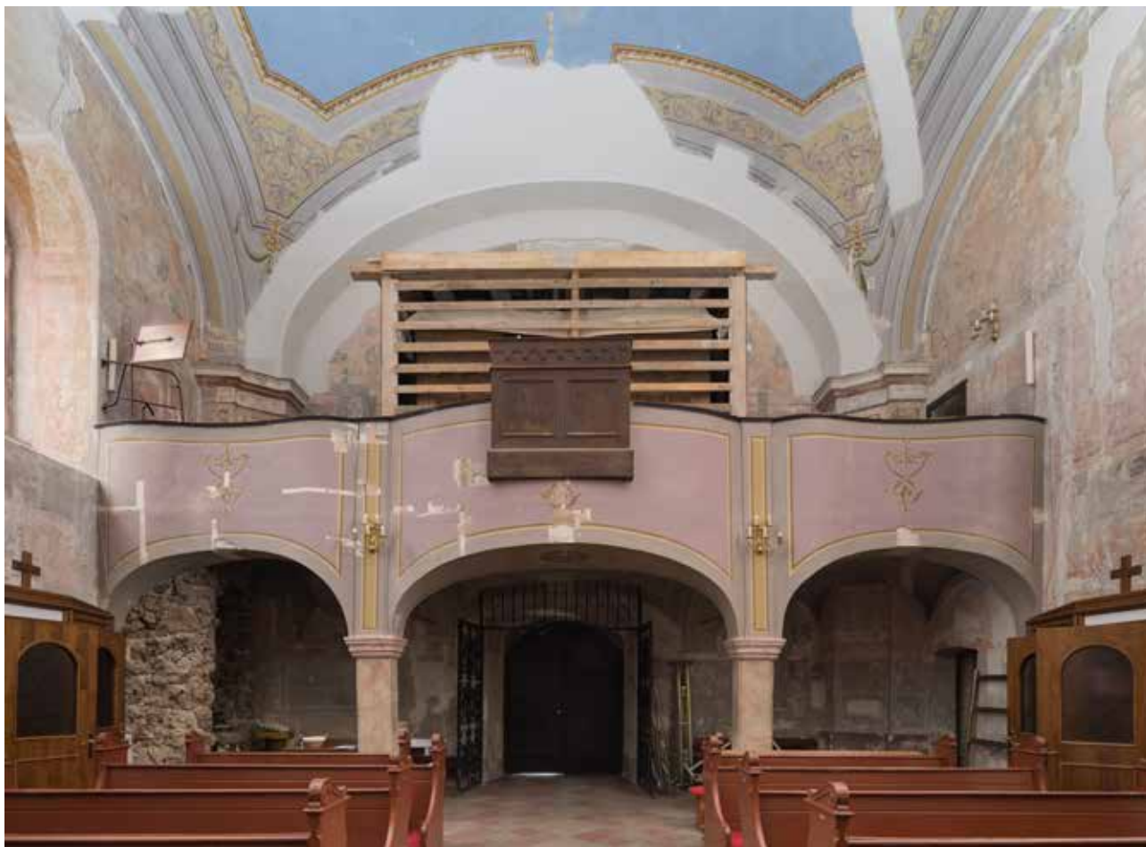
17 Pogled prema pjevalištu nakon završenih radova (foto: Katarina Gavrilica, HRZ, 2023.)
