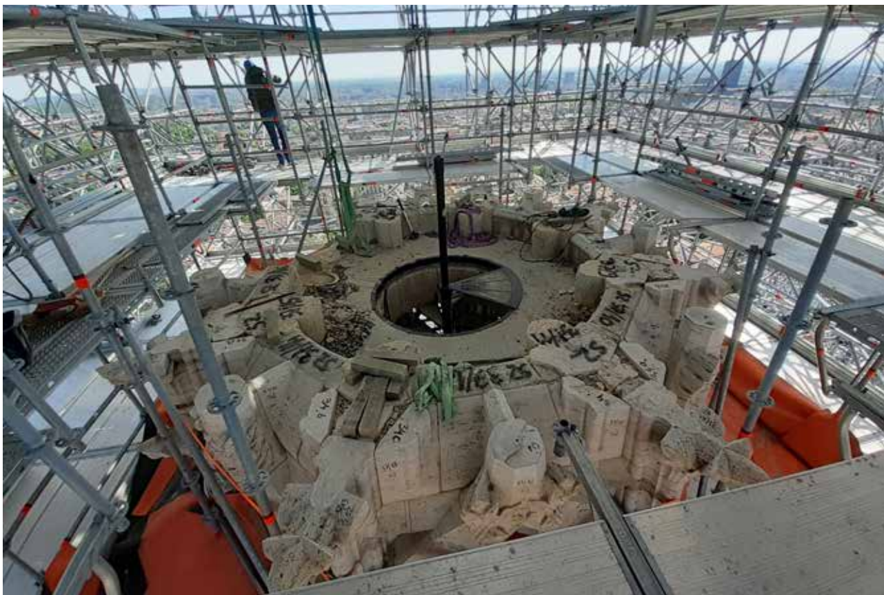
4 Razgradnja oštećenih kamenih elemenata sa sjevernog zvonika katedrale Uznesenja Marijina na Kaptolu (Fototeka, GZZSKP, 2024.)
