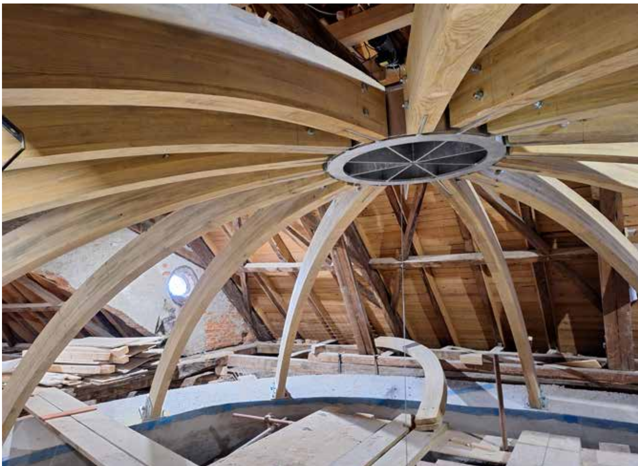
14 Zabok, župna crkva sv. Jelene Križarice, tijekom montiranja nove kupole nad lađom (foto: V. Jakaša Borić, KO KR, 2024.)
