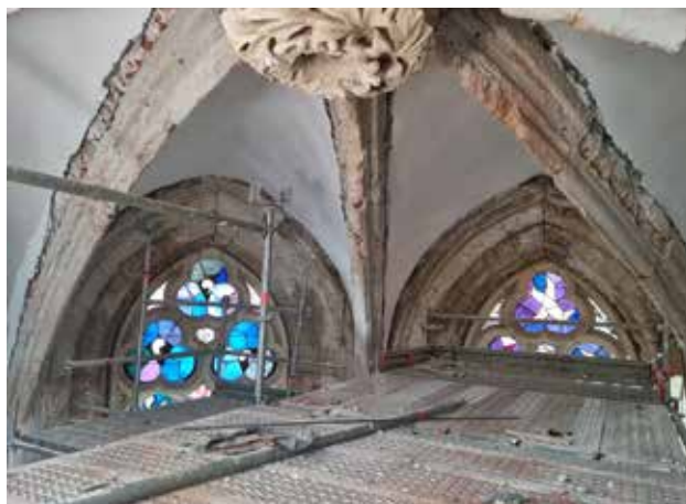
8 Kamena gotička rebra svodova i okvira prozora u svetištu crkve sv. Franje Asiškog na Kaptolu (Fototeka, GZZSKP, 2021.)
