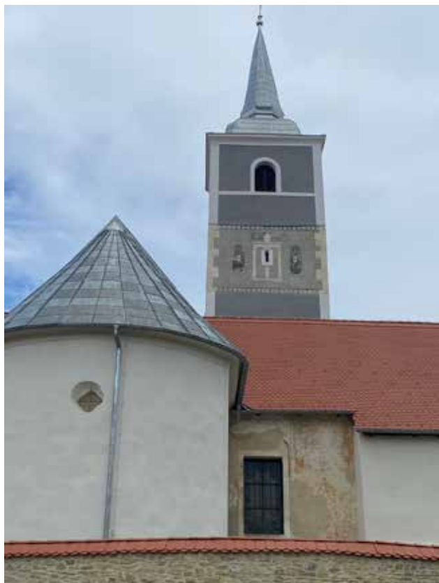
3 Hrašćina, župna crkva sv. Nikole, vanjština sa zidnim oslicima na južnom pročelju lađe i zvonka nakon radova konstrukcijske sanacije i obnove pročelja (foto: V. Jakaša Borić, KO KR, 2024.)
