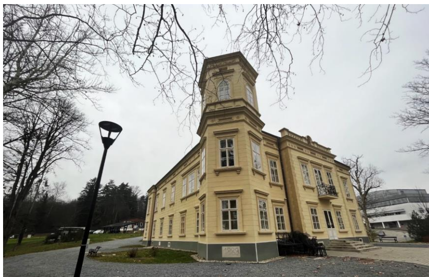
Slika 5.4 Pročelje dvorca nakon obnove.
