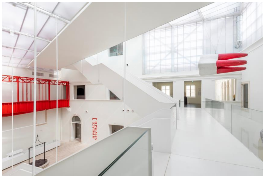
Slika 5.7 Unutarnje dvorište nakon obnove.
