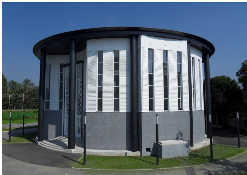
Slika 5.2 Pročelje paviljona nakon obnove.
