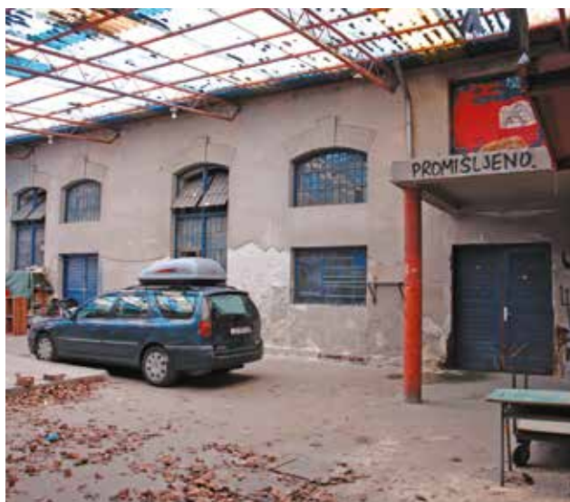
18 Pogled na istočno krilo Ledane i nekadašnju strojarnicu (foto: K. Galović, 2017.)
