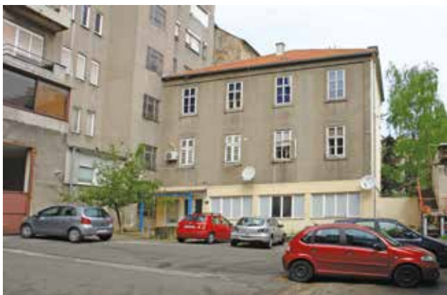
16 Upravna zgrada Zagrebačke ledane (foto: K. Galović, 2017.) Zagreb Ice Factory administration building (photo: K. Galović, 2017)
