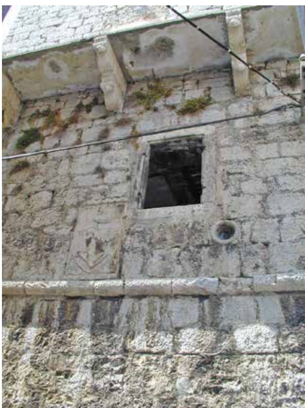
14 Kamene konzole za balkon (foto: I. Glavaš) Stone corbels for the balcony (photo: I. Glavaš)
