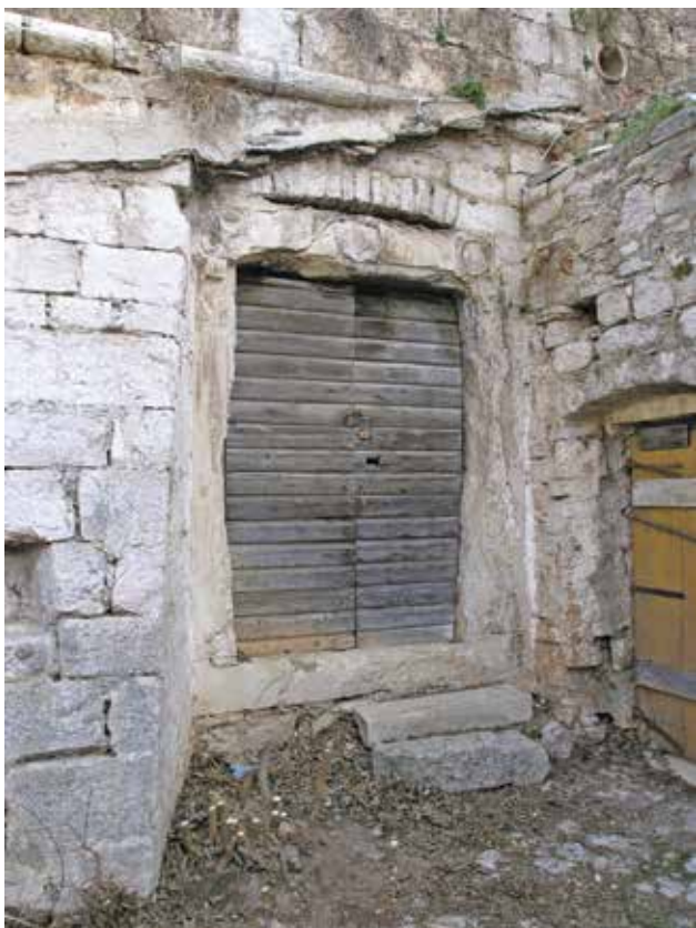
9 Glavna ulazna vrata u Čorićev toranj (foto: I. Glavaš) Čorić Tower main entrance door (photo: I. Glavaš)
