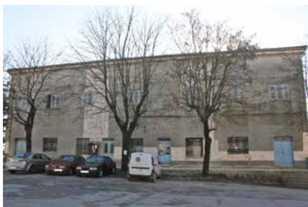
17 Zapadno pročelje bivše zgrade Općine i ljekarne, kasnije Zadrugnog doma (foto: B. Nefat, 2016.)
