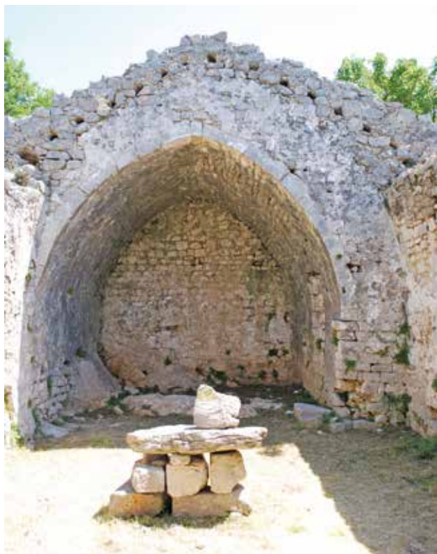
9 Pogled na svetište sa šiljato-bačvastim svodom, crkva sv. Vida, Vidovgrad (Fotodokumentacija HRZ-a)
