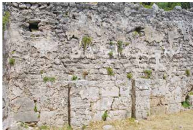
10 Sjeverni zid broda crkve s lezenama u donjem dijelu zida koje pripadaju starijoj fazi crkve, crkva sv. Vida, Vidovgrad (Fotodokumentacija HRZ-a)
