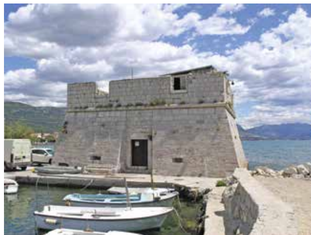
10 Kaštel Nehaj u Kaštel Štafiliću (foto: I. Glavaš) Nehaj Castle in Kaštel Štafilić (photo: I. Glavaš)
