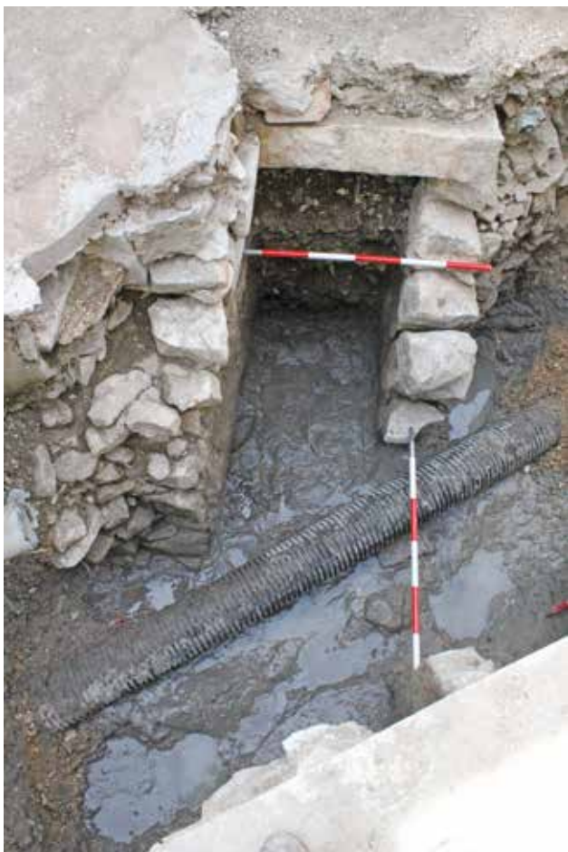
14 Segment kanala razidan za potrebe postavljanja novih cijevi kanalizacije i vodovoda, a nakon izrade konzervatorskog elaborata (foto: I. Pleština, fototeka Konzervatorskog odjela u Trogiru, 2016.)
