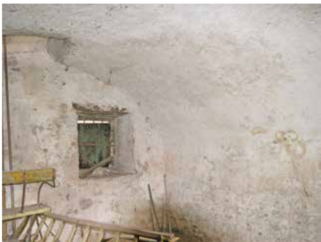
5 Svod u prizemlju Čorićevog tornja (foto: I. Glavaš) Čorić tower ground floor vault (photo: I. Glavaš)
