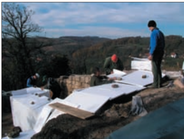
Gradišće, Čanjevo, zimska zaštita (foto: L. Bekić)
