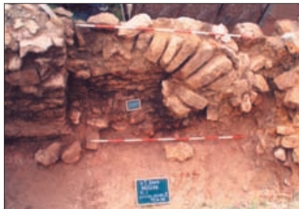
Varaždinske Toplice, istočni zid bazilike - detalj rasteretnog luka prozora (foto: D. Nemeth-Ehrlich)
