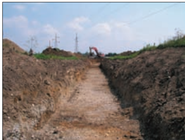
Stara Ves, iskop kanala
