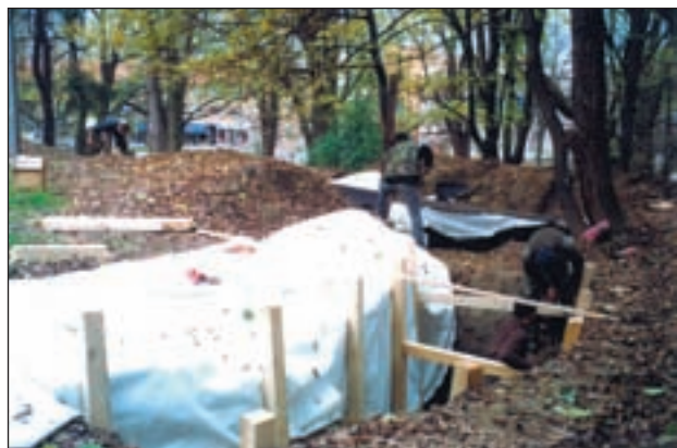
Virovitica, zaštita kule geotekstilom i izgradnja privremene nadstrešnice (foto: S. Salajić)
