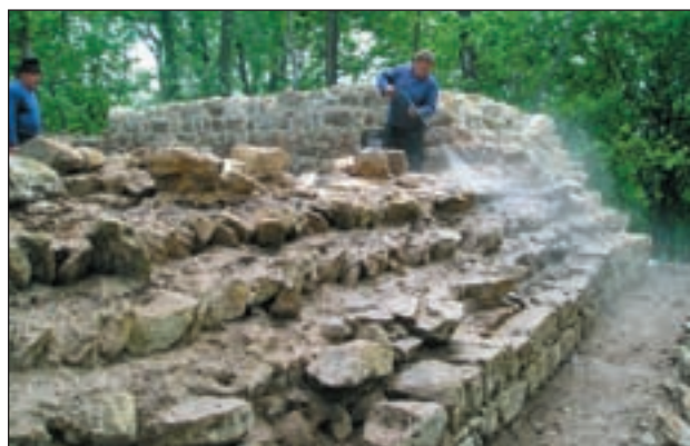
Utvrdna Paka, sjeverni obrambeni zid tijekom konzervacije – ispiranje vodom pod pritiskom nakon demontaže (foto: B. Šimek)
