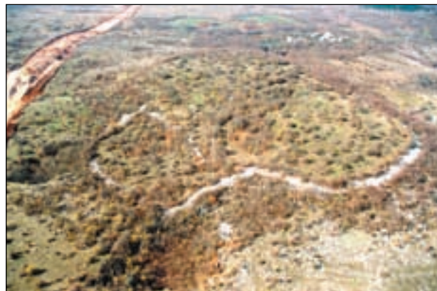
Lipova glavica, pogled s juga, na desnoj strani trasa Autoceste Zagreb – Split u izgradnji
