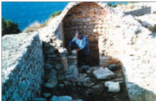
Gradina, ostava za hranu nakon djelomične rekonstrukcije svoda (foto: I. Pedišić)
