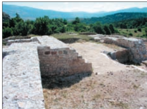
Udbina - stolnica sv. Jakova, konzervirani dijelovi zidova (foto: F. Nedved)
