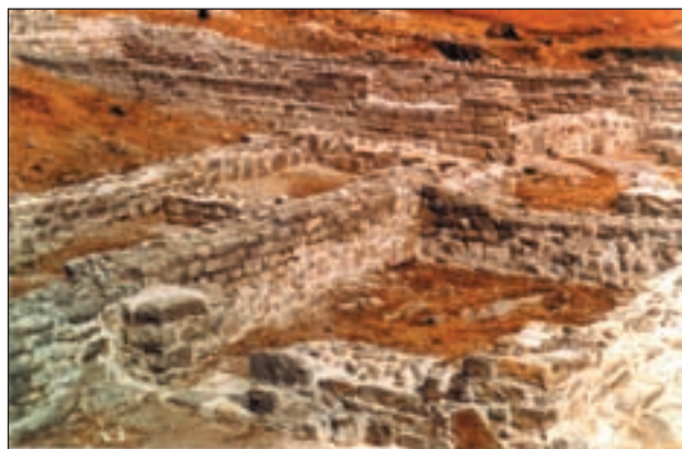
Bribirska Glavica, konzervirani dio ostataka srednjovjekovnih građevina (iz stare Marunove kuće) (foto: I. Pedišić)
