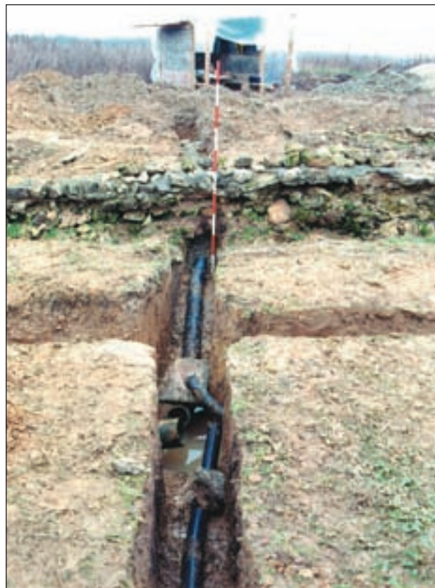
Ciglenice, Osekovo, izvedba drenaže na lokalitetu (foto: A. Bobovec)
