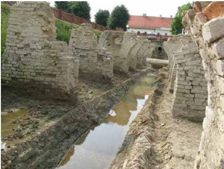
Pogled na izvorno stupište mosta u Tvrđavi Brod
