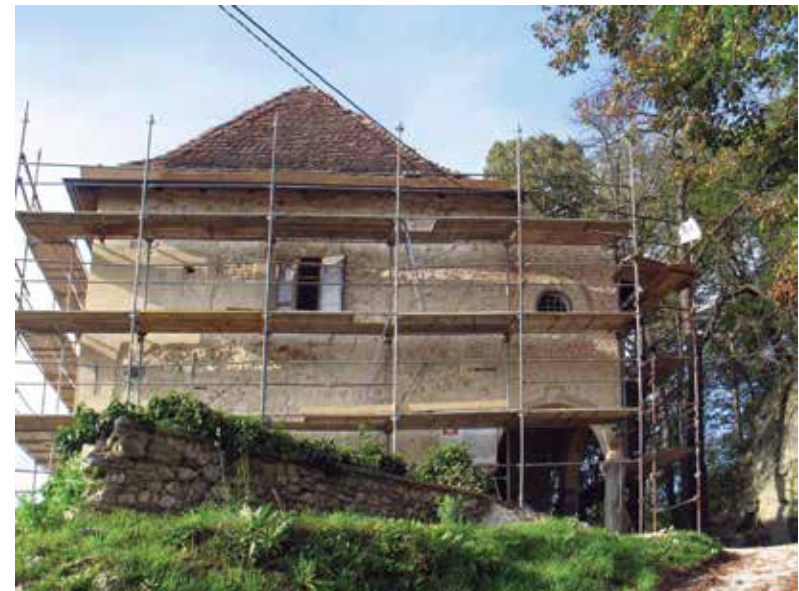
Stari grad - Palas za vrijeme radova sanacije
