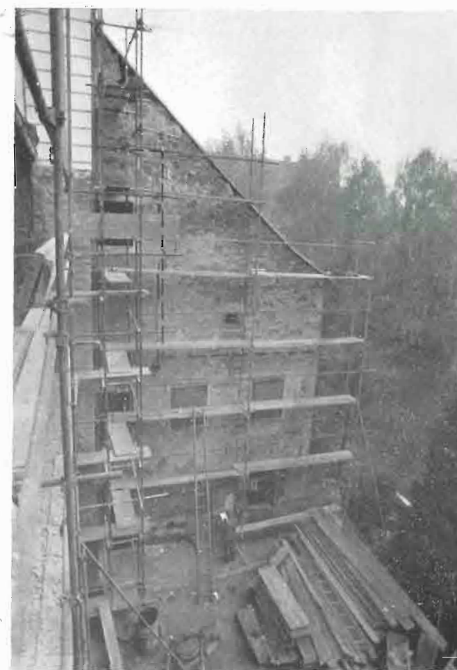
31 Sakristija, sjeverno pročelje izvedeno u 18. st. Strelice označavaju gabarite pregradnje iz 1727.
