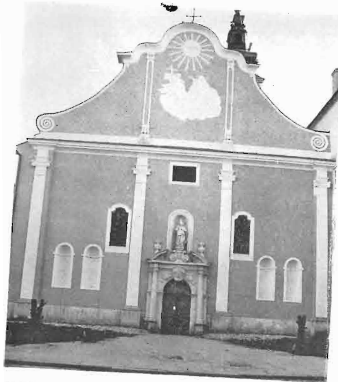
37 Glavno pročelje nakon obnove 1985.
