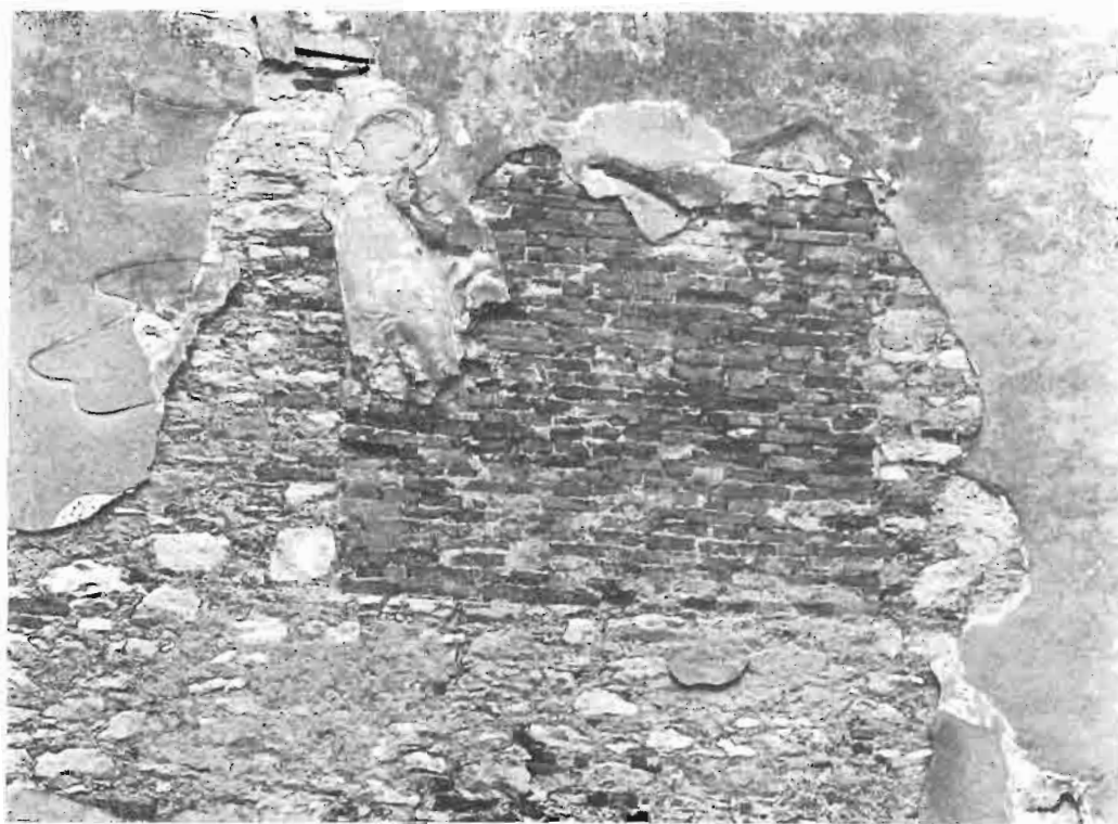
10 Glavno pročelje, trag zazidanog prozora iz 17. st. na zabatu i ostatak reljefa s prikazom Presvetoga Trojstva 10 Main facade, 17th cent. walled window trace on the gable and a relief fragment showing Holy Trinity
