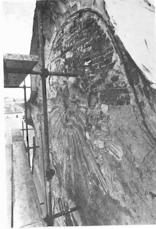
12 Glavno pročelje, detalj reljefa s prikazom Presvetog Trojstva, golubica Duha svetoga. Strelica pokazuje trag nadvoja okruglog prozora iz 17. st. 12 Main facade, a relief detail showing Holy Trinity, Holy Ghost's dove; the arrows indicate the lintel of a round window from 17th cent.
