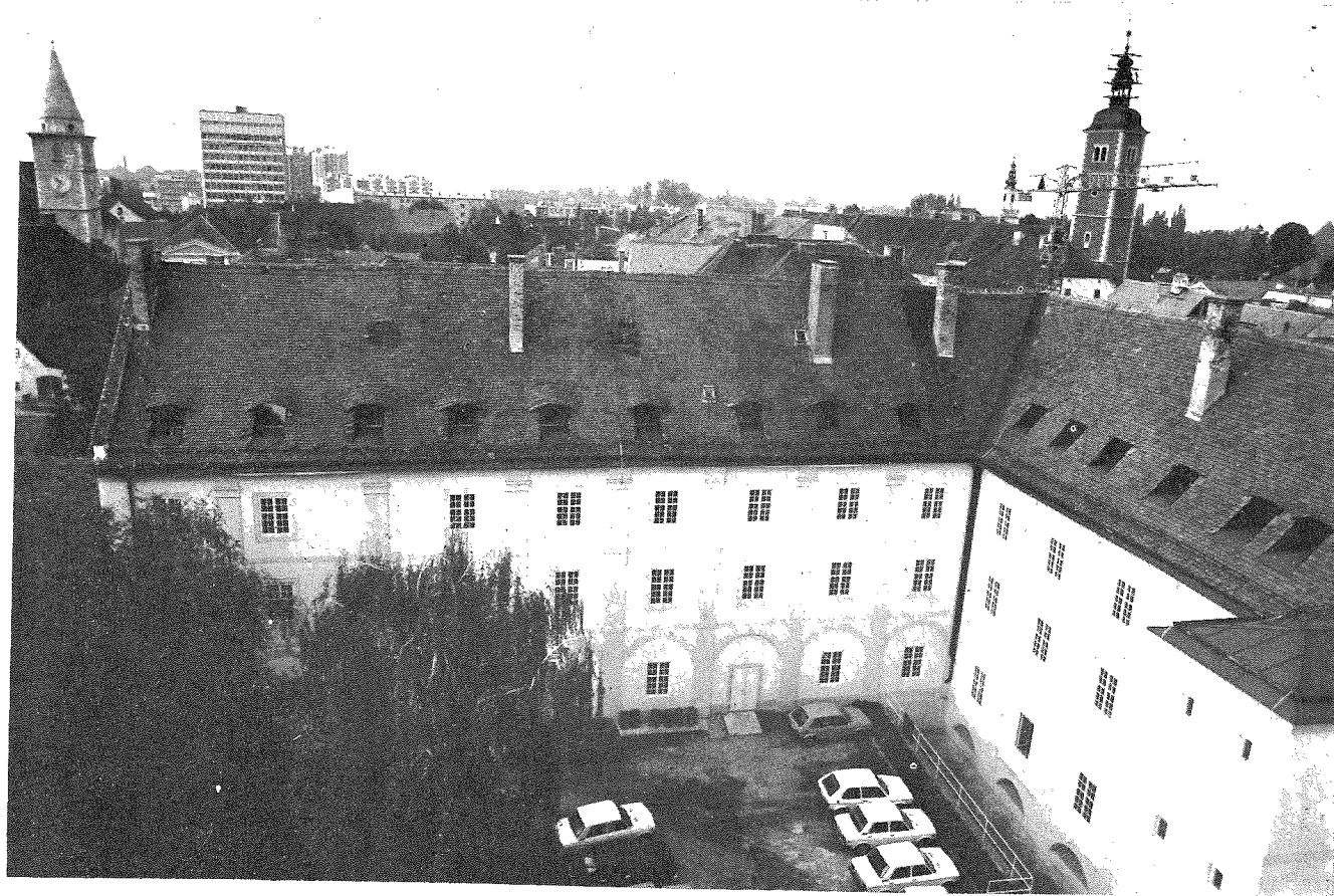
3 Isusovački, kasnije pavlinski samostan (1679—1691) nakon adaptacije za Fakultet organizacije i informatike. Tavanski prozori na zapadnom (lijevom) krilu izvedeni su prema projektu S. Planića (1976), a na sjevernom (desnom) u drugoj fazi obnove oni su izvedeni bez razumijevanja za rafiniranost valovitih, »baroknih« streha prozorskih niša, koje su ovdje izravnane
