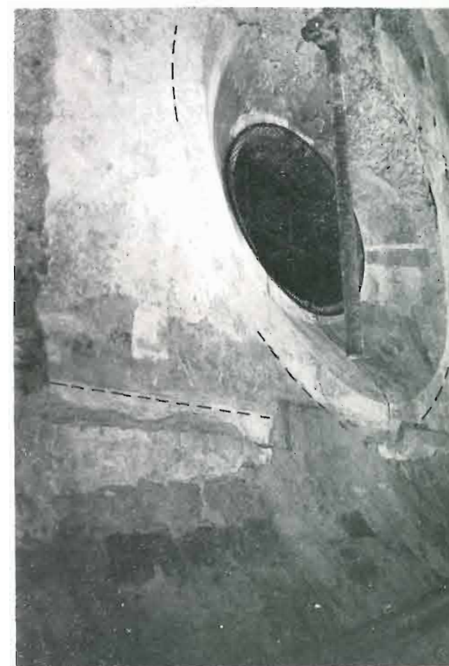
20 Zapadno pročelje, sonda uz prozor empore s tragom naslikanog okvira i završnog vijenca
