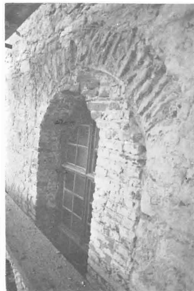
9 Glavno pročelje, prozor iz 18. st. unutar zazidanog otvora prozora iz 17. st.
