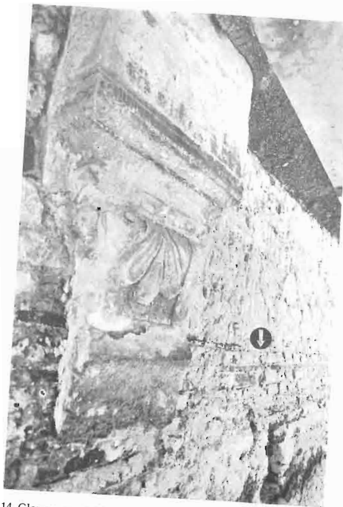
14 Glavno pročelje, baza pilastra iz 18. st. u gornjem katu. Strela pokazuje otučeni zabatni vijenac iz 17. st. 14 Main facade, 18th cent. pilaster base in the upper floor; the arrow shows the damaged gable moulding from 17th cent.
