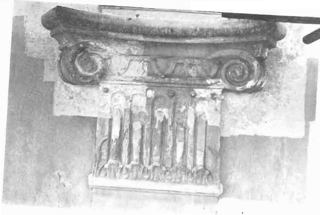
13 Glavno pročelje, kapitel pilastra iz 18. st. 13 Main facade, pilaster capital from 18th cent.
