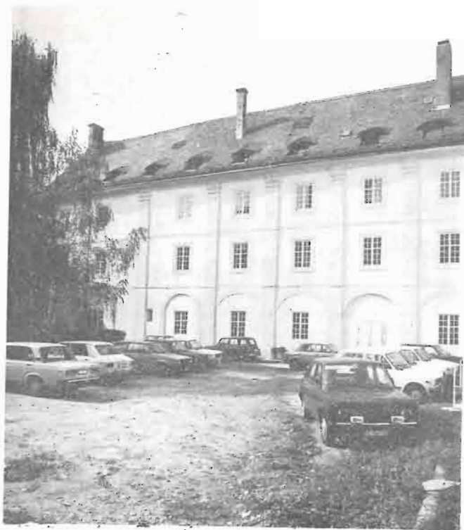
1 Zapadno krilo isusovačkoga samostana (17. st.). Prilikom adaptacije za Fakultet organizacije i informatike (arh. S. Planić, 1976) otvoreni su krovni prozori
