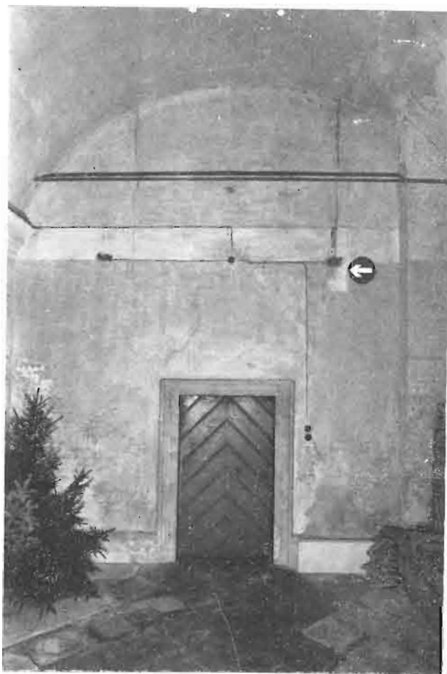
18 Nekadašnji bočni crkveni portal u unutrašnjosti lauretanske kapele. Strelica pokazuje naslikani okvir zazidanoga prozora
