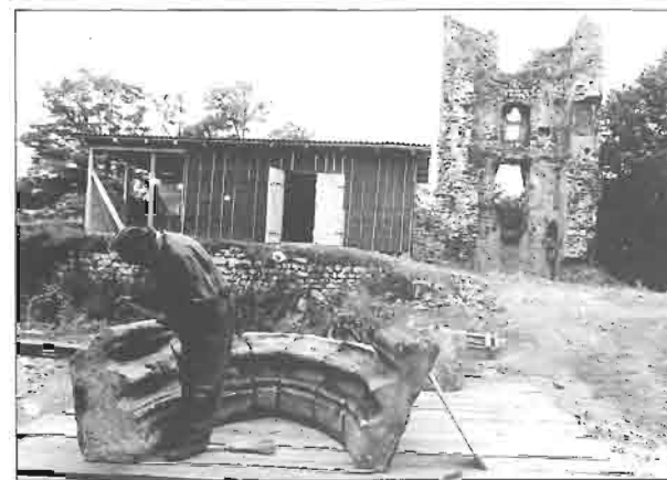
46 Slaganje dijelova nadvoja portala pjevališta (1986.)
