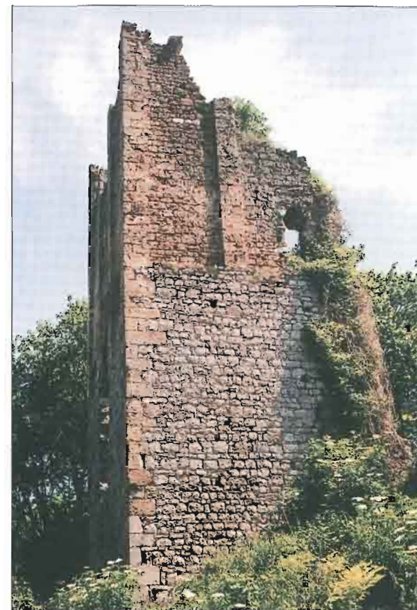
79 Frankopanska kula, pogled na južno pročelje (1999.) Frankopan Tower, view of the southern façade (1999)
