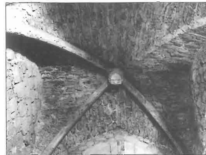
53 Kapele sv. Trojstva, supstrukcija, pogled na svod južnoga prostora prije radova (1982.)
