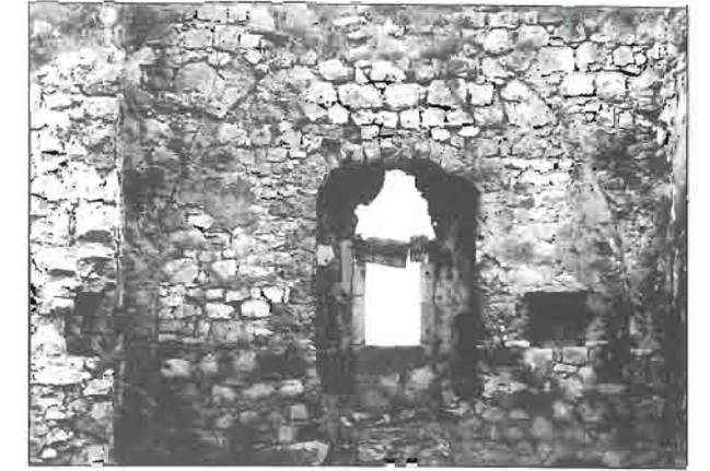
91 Frankopanska kula, unutrašnjost drugoga kata, pogled na zapadni zid
