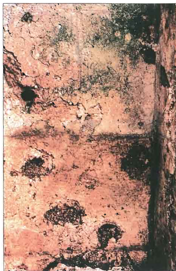
84 Frankopanska kula, žbuka s oslikanim kvadrima uz zapadni prozor drugoga kata
