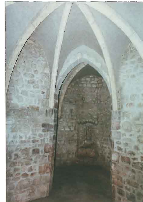
55 Kapela sv. Trojstva, supstrukcija, pogled na istočni prostor nakon radova
