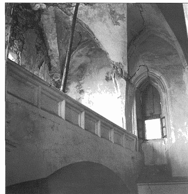
36 Unutrašnjost kapele sv. Trojstva, sjeverni dio svoda pjevališta (G. Jurišić, 1963.)
