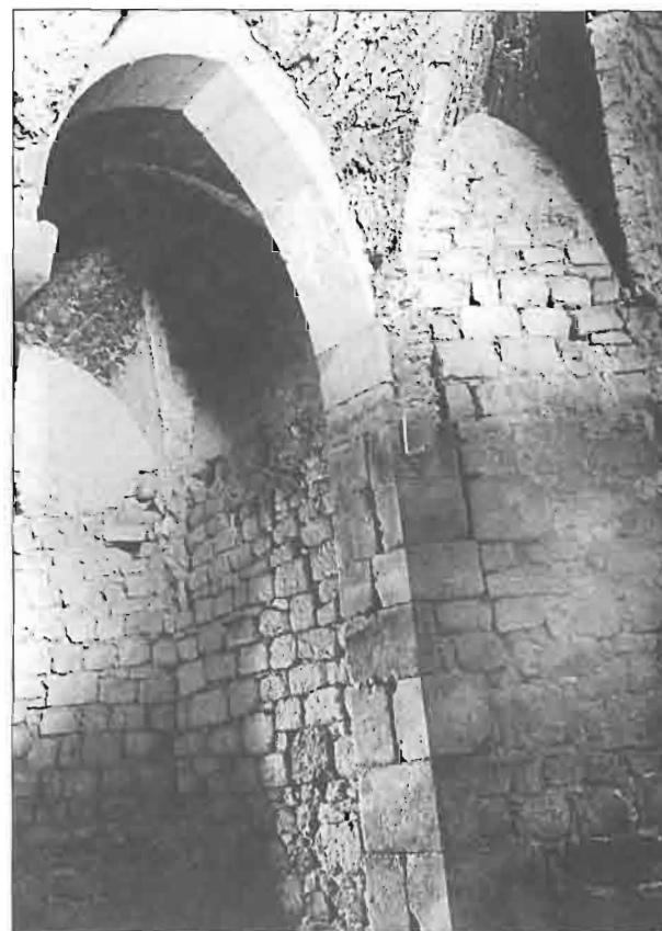
52 Kapela sv. Trojstva, supstrukcija, pogled na istočni prostor prije radova (1982.)
