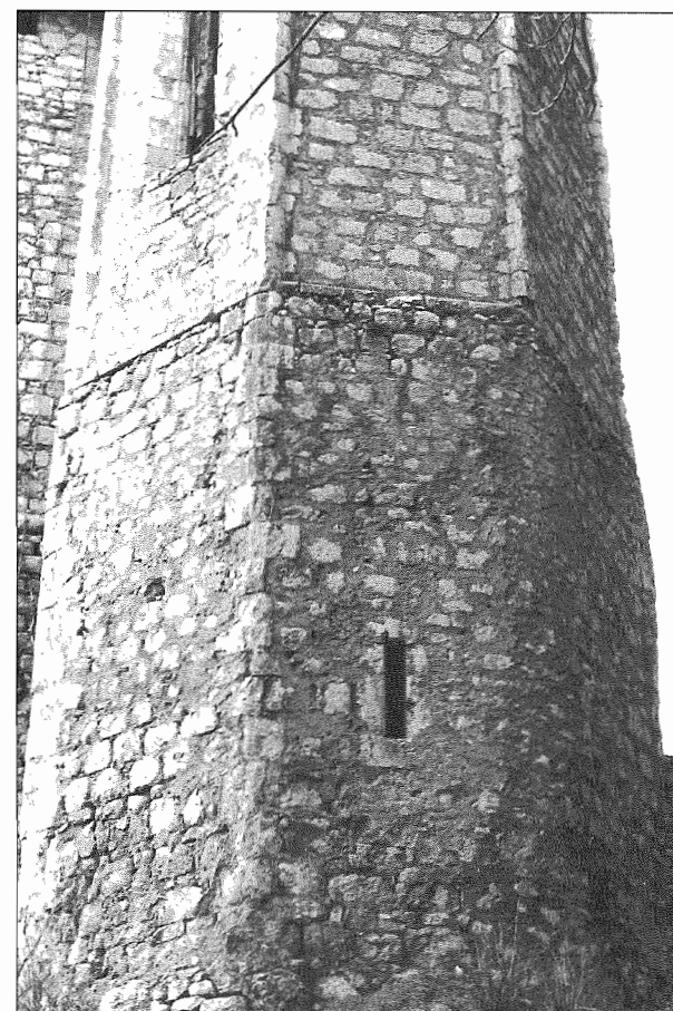
43 Kapela Sv. Trojstva, istočno pročelje, stanje 1982. Chapel of the Holy Trinity, eastern façade, situation in 1982
