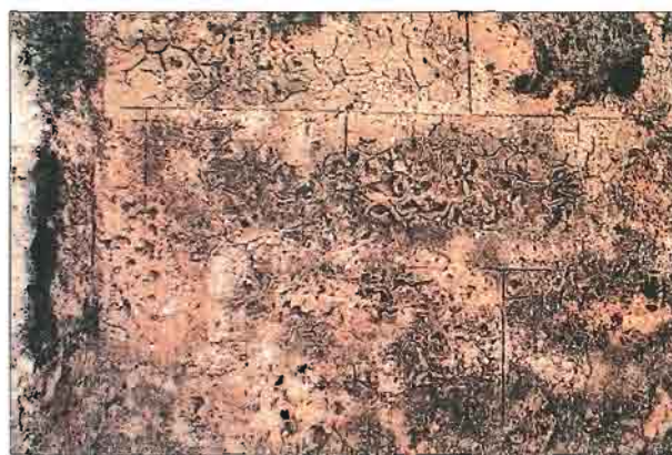
83 Frankopanska kula, ostaci žbuke s ugrebanim crtežom kvadara na zapadnom pročelju
