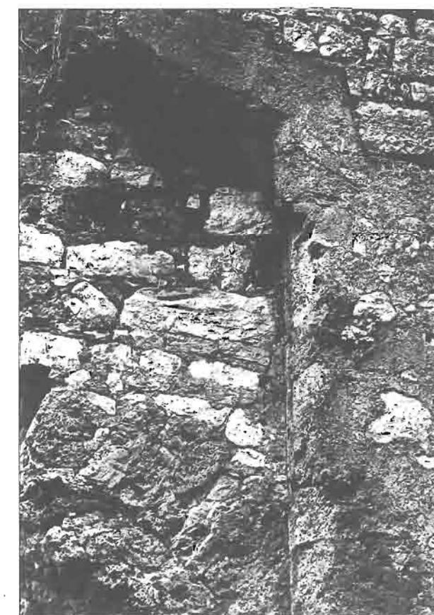
87 Frankopanska kula, sjeverno pročelje, okvir s utorom za kovanu rešetku ulaznih vrata koja se diže
