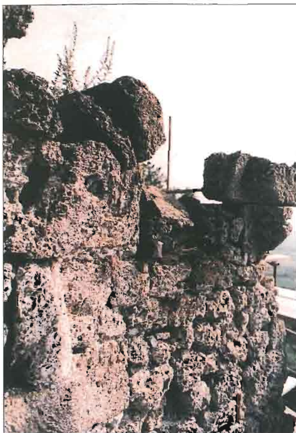
82 Frankopanska kula, ostaci sačuvanoga slijepog luka na južnom pročelju
