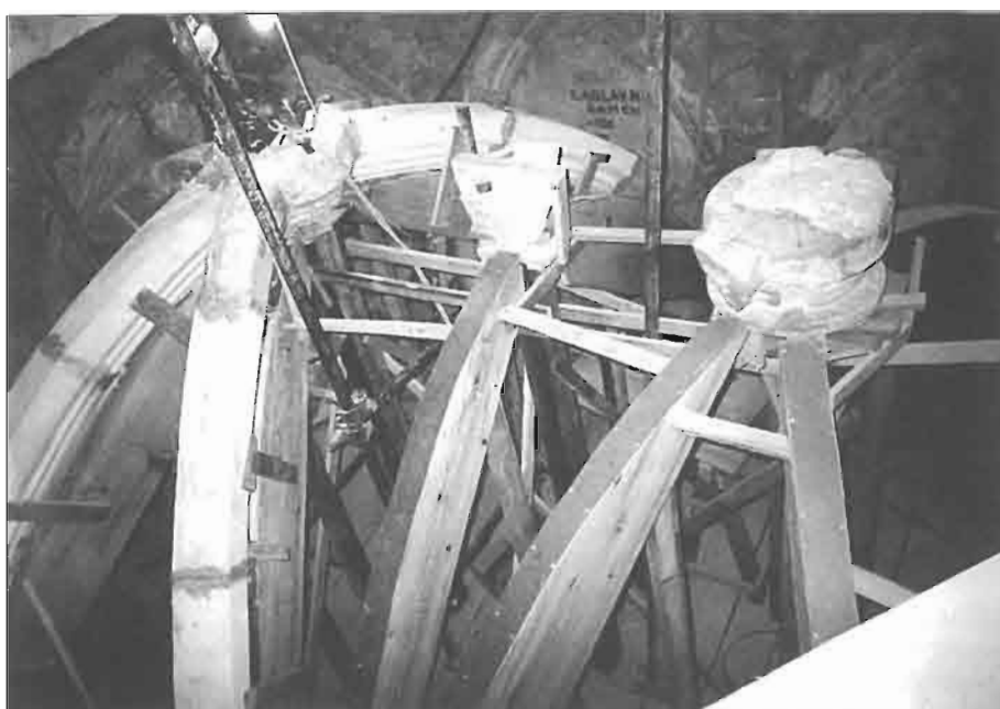
56 Kapela sv. Trojstva, kapela Majke Božje od Sedam žalosti, postavljanje svodnih rebara Chapel of the Holy Trinity, Chapel of the Madonna of the Seven Sorrows, putting in the ribs
