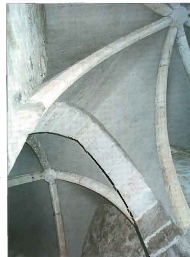
54 Kapela sv. Trojstva, supstrukcija, pogled na rekonstruirana svodna rebra
