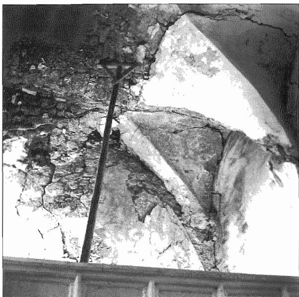
37 Unutrašnjost kapele sv. Trojstva, pogled na pjevalište i sjeverni zid broda, G. Jurišić, 1963.)
