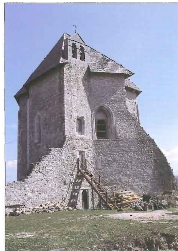
47 Kapela sv. Trojstva, stanje nakon dovršetka druge faze obnove zapadnoga pročelja (1987.)
