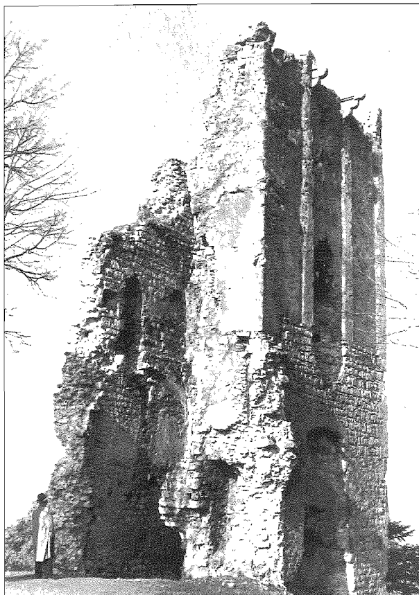
28 Pogled sa sjeveroistoka na frankopansku kulu (I. Medar, AG foto, 1952.)
