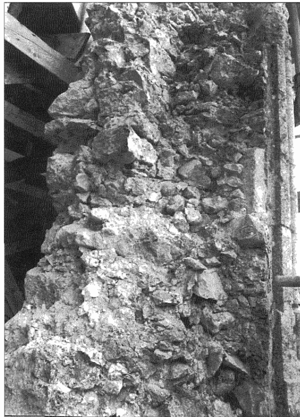
96 Kapela sv. Trojstva, strukture zida unutar zapadnoga pročelja
