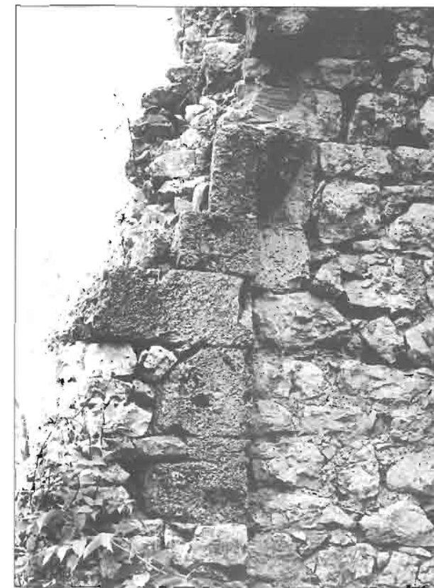
90 Frankopanska kula, jugoistočni kut prostora prvoga kata s ostacima niše stubišnih vrata i ugaonom konzolom svodne pete
