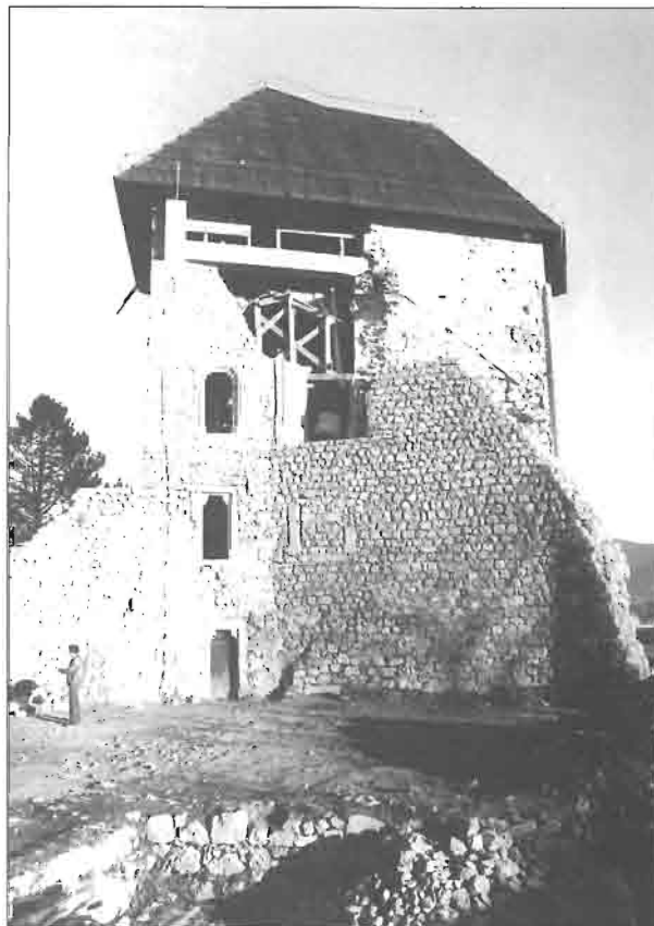
45 Kapela sv. Trojstva, stanje nakon dovršetka prve faze obnove zapadnoga pročelja 1986.
