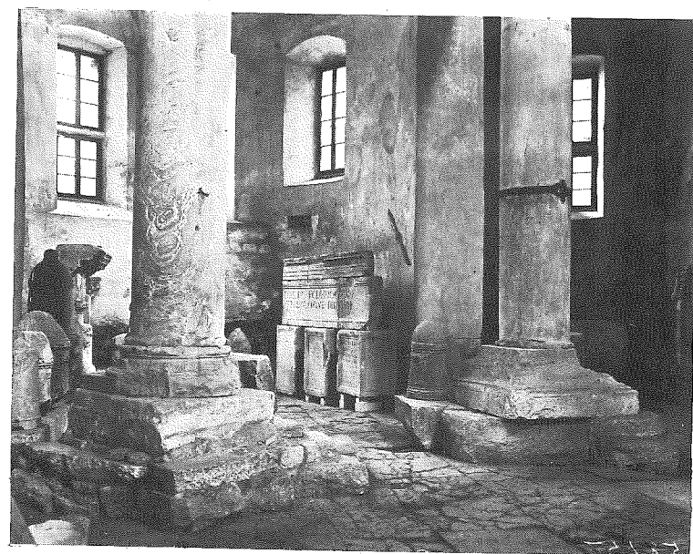
21 Unutrašnjost glavne apside, stanje oko 1910. god. Interior of the main apsis, 1910
