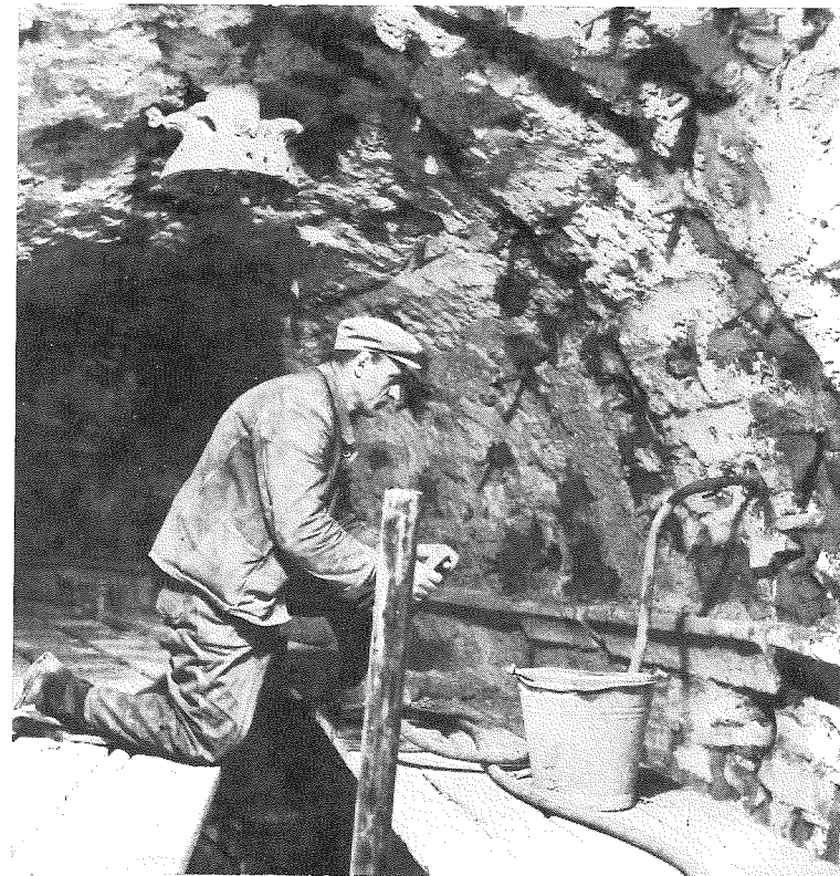
34 Postupak injektiranja, 1970. god. Injection method, 1970
