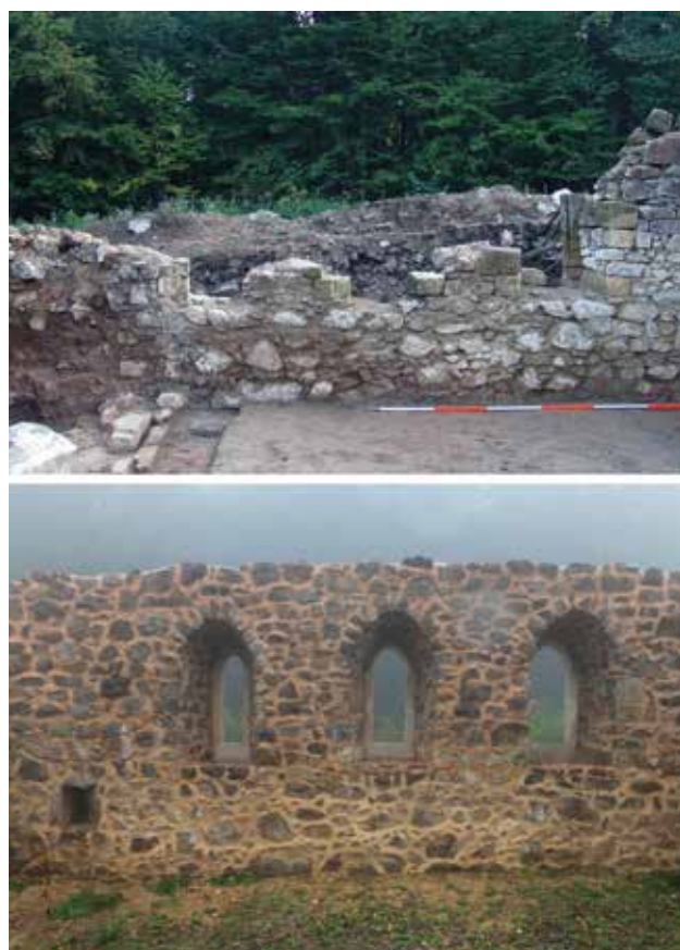
44 - 45 Pogled na sjeveroistočni zid kapitularne dvorane/refektorija prije i nakon dovršetka radova (foto: T. Pleše, 2006. i 2016.)
