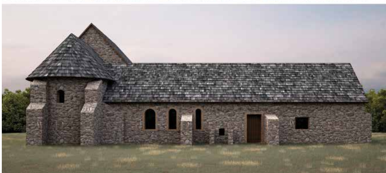
53 - 55 Pogled sa sjeveroistoka na pavlinski samostan sv. Petra po dovršetku istraživanja, po dovršetku građevinskih radova konzerviranja i prezentiranja te prikaz idealne rekonstrukcije (foto: M. Braun, 2007., T. Pleše, 2015., izrada: „Vektra d.o.o.“, 2015.)
