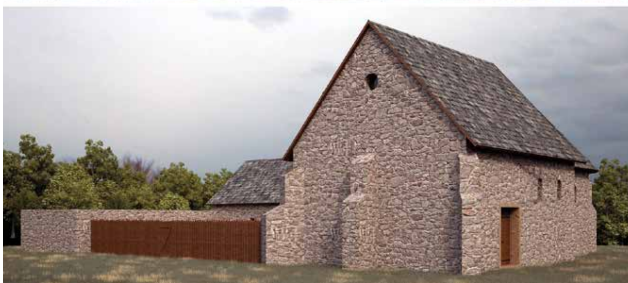
62 - 64 Pogled s juga na pavlinski samostan sv. Petra po dovršetku istraživanja, po dovršetku građevinskih radova konzerviranja i prezentiranja te prikaz idealne rekonstrukcije (foto: M. Braun, 2007., T. Pleše, 2015., izrada: „Vektra d.o.o.“, 2015.)
