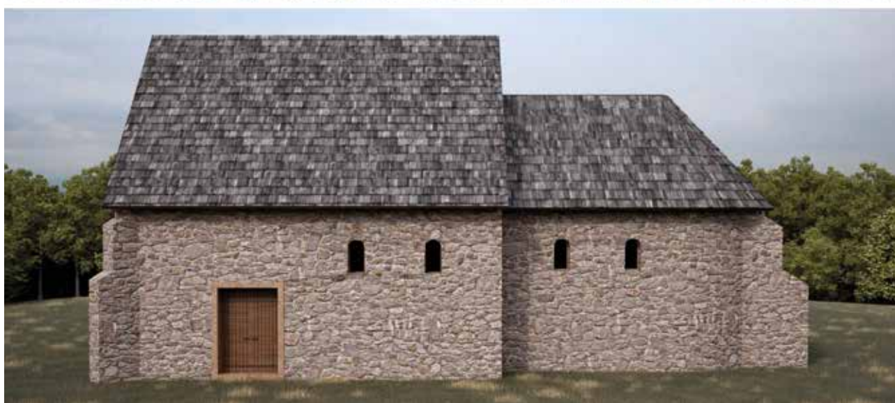
59 - 61 Pogled s jugoistoka na pavlinski samostan sv. Petra po dovršetku istraživanja, po dovršetku građevinskih radova konzerviranja i prezentiranja te prikaz idealne rekonstrukcije (foto: M. Braun, 2007., T. Pleše, 2015., izrada: „Vektra d.o.o.“, 2015.)
