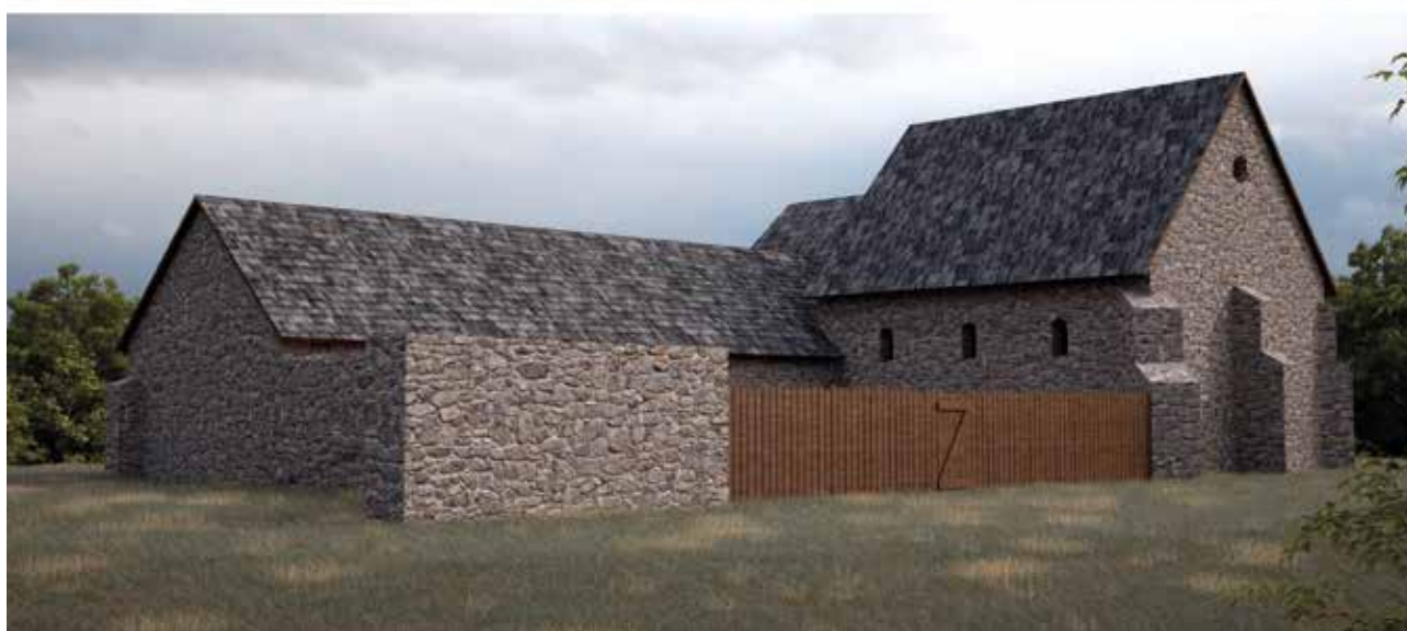
68 - 70 Pogled sa zapada na pavlinski samostan sv. Petra po dovršetku istraživanja, po dovršetku građevinskih radova konzerviranja i prezentiranja te prikaz idealne rekonstrukcije (foto: M. Braun, 2007., T. Pleše, 2015., izrada: „Vektra d.o.o.“, 2015.)
