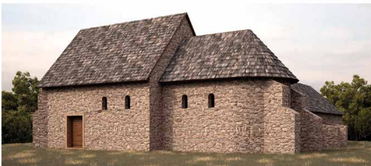
56 - 58 Pogled s istoka na pavlinski samostan sv. Petra po dovršetku istraživanja, po dovršetku građevinskih radova konzerviranja i prezentiranja te prikaz idealne rekonstrukcije (foto: M. Braun, 2007., T. Pleše, 2015., izrada: „Vektra d.o.o.“, 2015.)
