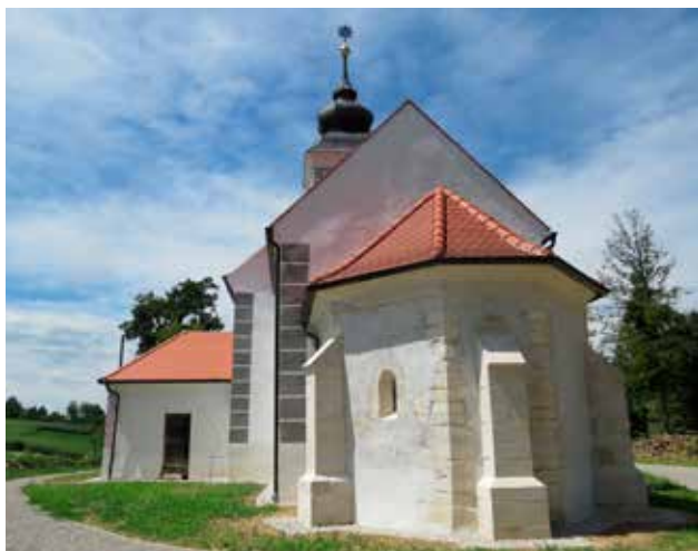
Gotalovec, Pogled na KONTRAFOR svetišta kapele sv. Petra (fototeka Konzervatorskog odjela u Krapini, 2016.)
