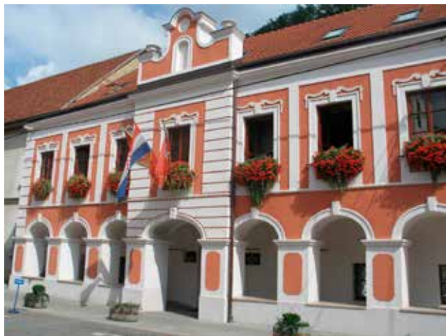
Krapina, Zgrada MAGISTRATA (fototeka Konzervatorskog odjela u Krapini, 2009.)
