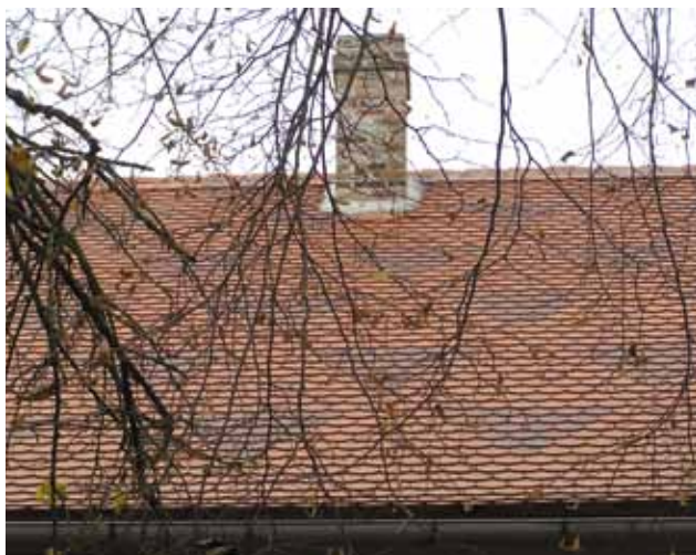
13 Krovište nakon obnove drvene konstrukcije, prekrivanja i rekonstrukcije dimnjaka. Sljemenjaci su učvršćeni mortom, stanje 2011. (foto: Z. Čiča)
