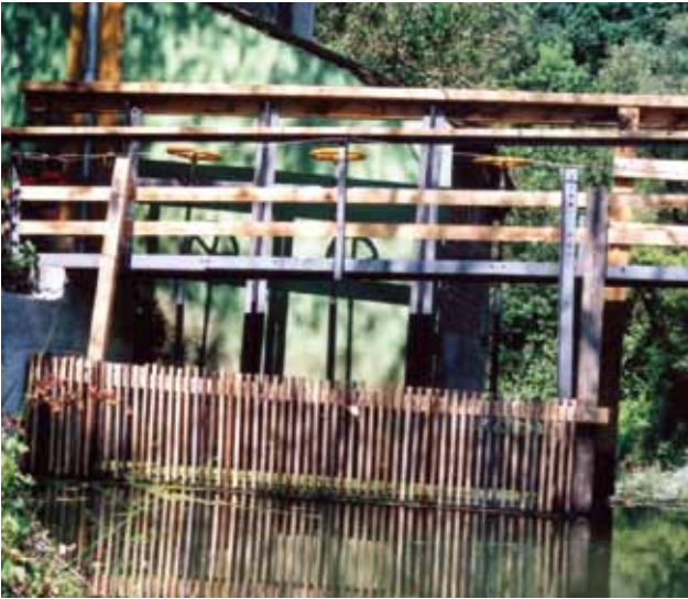
15 Dio ustave s mostom i zaštitnom rešetkom za sakupljanje nepoželjnih naplavina, stanje 2007. (foto: A. Mlinar)
