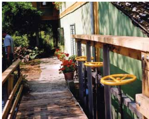
14 Dio mosta i vanjskog postrojenja nakon obnove, stanje 2007. (foto: A. Mlinar)
