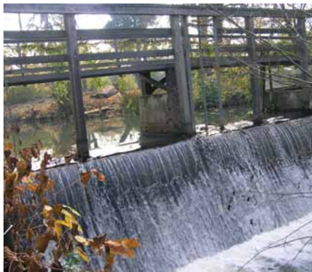
16 Slap iznad turbine nastao nakon prelijevanja preko brane, stanje 2011. (foto: Z. Čiča)
