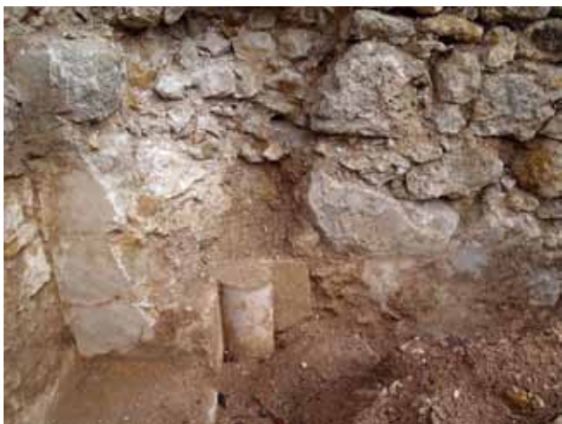
23 Proširenje sjevernog zida lađe, ostatci žbuke i polustup (služba) na spoju sjevernog i istočnog zida kapele utvrde Grebengrad otkriveni tijekom radova 2012. (foto: M. Korunek)
