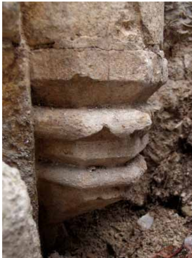
12 Konzola koja nosi polustup (službu) na spoju južnog i istočnog zida svetišta u unutrašnjosti kapele utvrde Grebengrad (foto: M. Korunek) Console carrying the jamb (service) at the junction of the south and east wall of the sanctuary inside the chapel of Fort Grebengrad photo: M. Korunek)
